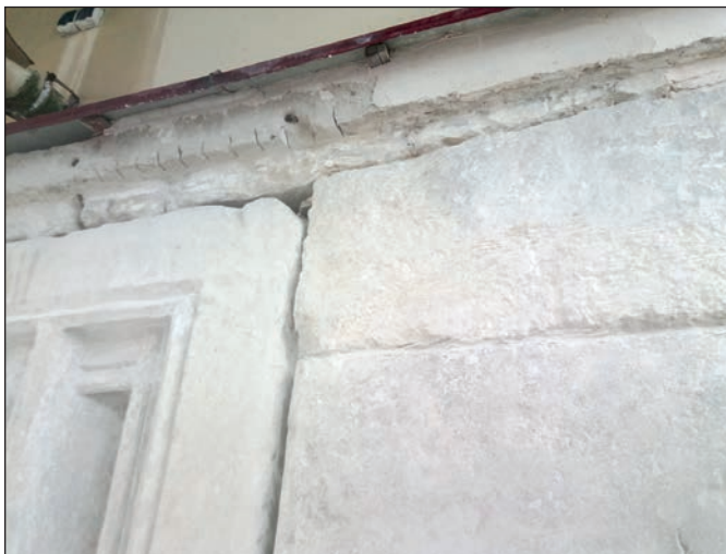
9. Zatarcie profilu gzymsu, fot. M. Jańczuk
