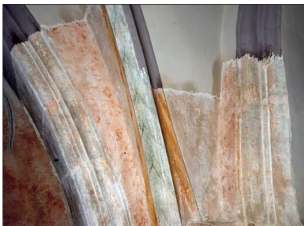
3. Kraśnik, kościół par., podchórze w trakcie usuwania przemalowań, fot. M. Filip, 2023
