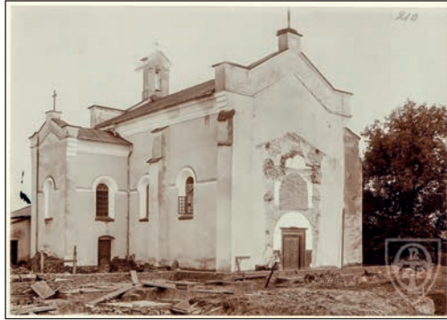
7. Zdjęcie kościoła św. Wojciecha obok fundamentów pod nowy kościół (fot. K. Baranowski, 1909)
