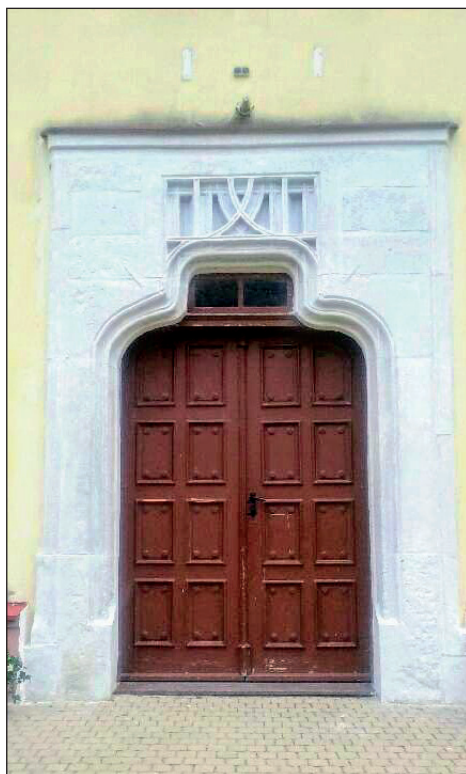
15. Portal po zakończeniu prac, fot. Artur Dyjak
