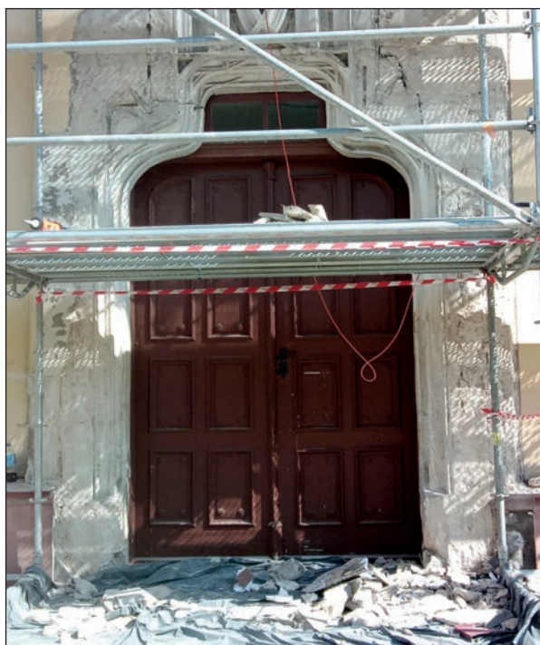
2. Portal po skuciu tynków, fot. M. Jańczuk
