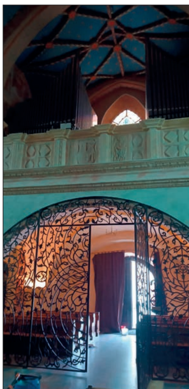
15. Kraśnik, kościół par., podchórze – ściany po pracach, fot. M. Filip, 2023
