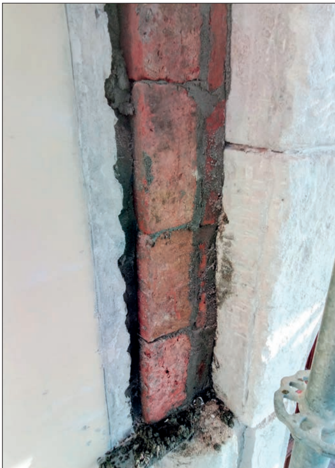
10. Wymurowanie ceglanej konstrukcji, fot. M. Jańczuk
