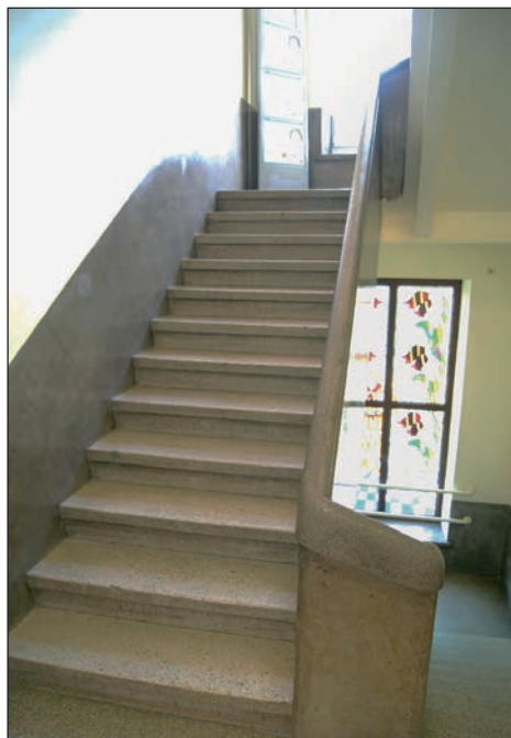
Fot. 2. Lastrikowa balustrada, schody i okładzina głównej klatki schodowej
