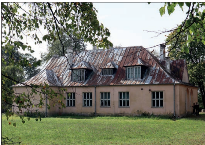
8. Budynek szkoły w Ol-szynie, gm. Rokitno, fot. M. Zieniewicz, 2023.
