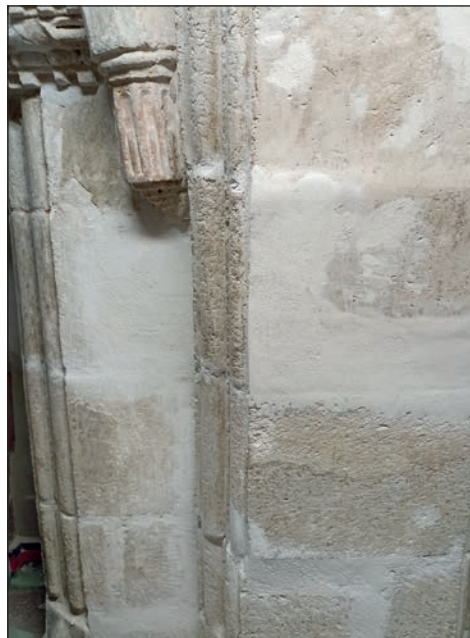
8. Kraśnik, kościół par., kamieniarka podchórze w trakcie prac, fot. M. Filip, 2023
