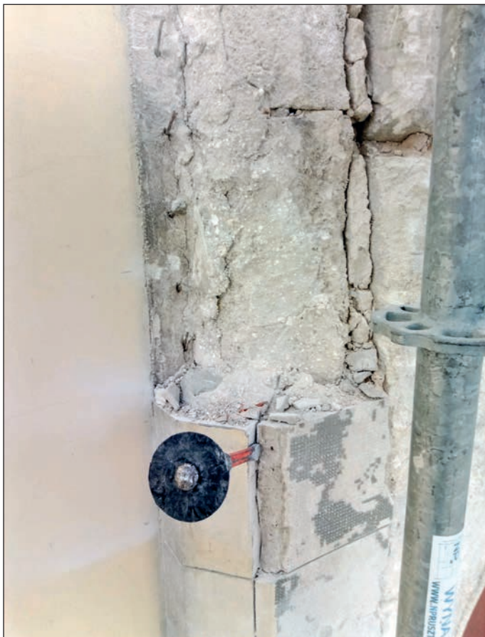
3. Stan wypraw tynkowych, fot. M. Jańczuk
