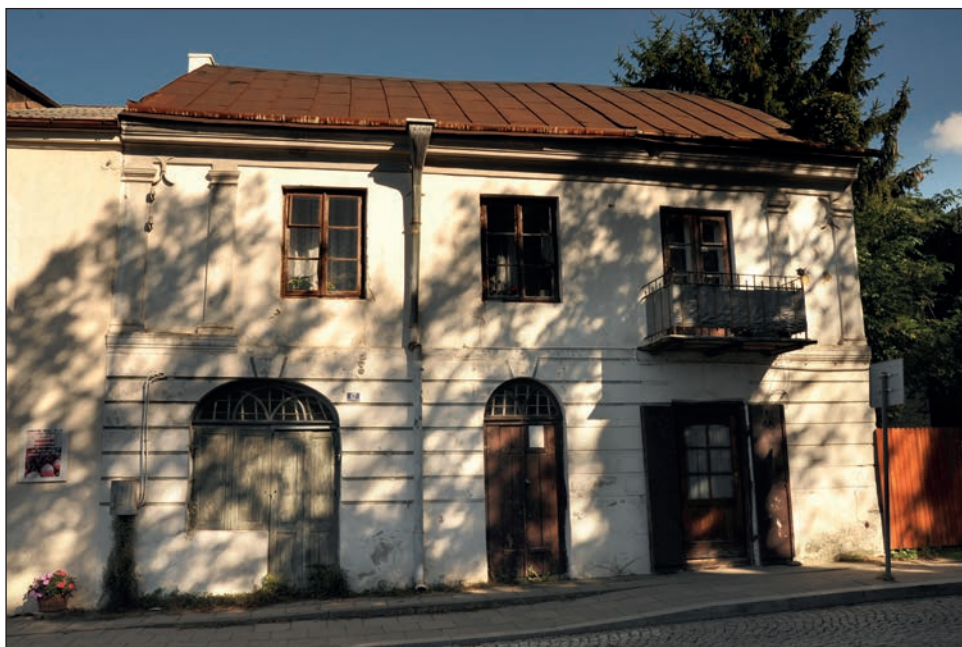
2. Kamienica własna Zilcherta w Kazimierzu Dolnym przy ul. Lubelskiej 17, fot. J. Studziński, 2022
