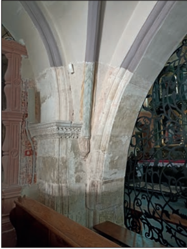
4. Kraśnik, kościół par., podchórze w trakcie usuwania przemalowań, fot. M. Filip, 2023
