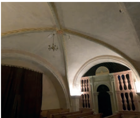
18. Podchórze po pracach konserwatorskich, fot. Kompleksowa Konserwacja Zabytków M. Filip A. Filip s.c., 2024
