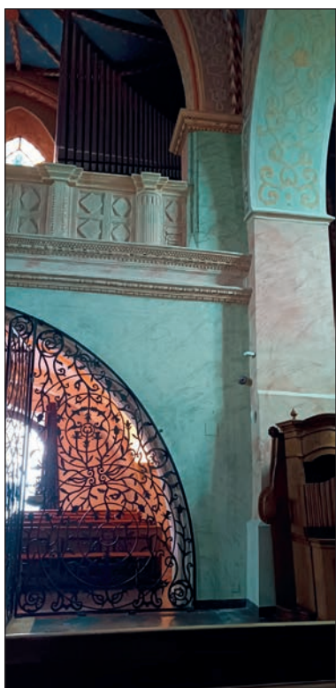
14. Kraśnik, kościół par., ściana czołowa podchórza po pracach, fot. M. Filip, 2023
