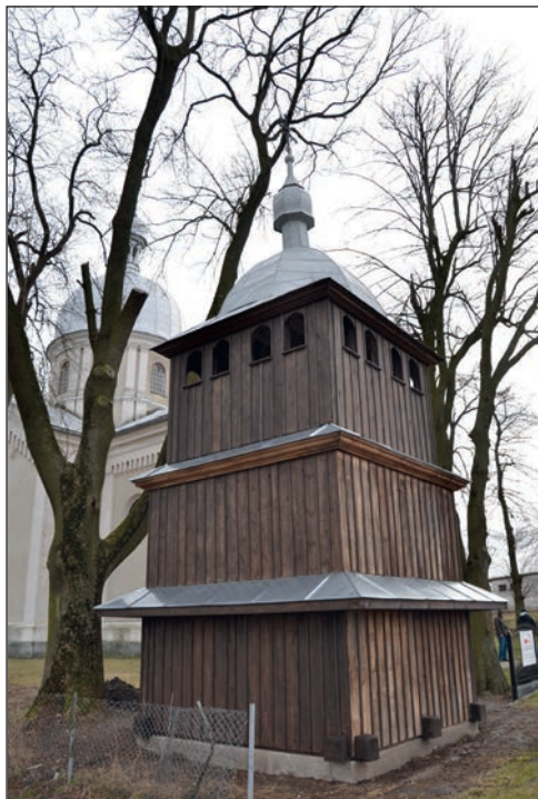
11. Drewniana dzwonnica na cmentarzu cerkiewnym (obecnie przykościelnym) w Szczepiatynie, fot. B. Stolarz
