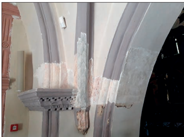
2. Kraśnik, kościół par., podchórze w trakcie usuwania przemalowań, fot. M. Filip, 2023
