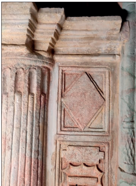
11. Kraśnik, kościół par., balustrada chóru w trakcie korekty, fot. M. Filip, 2023
