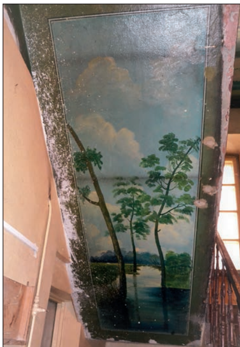
2. Chełm, kamienica przy ul. Lubelskiej 30, klatka schodowa – wystrój malarski, fot. A. Stawinoga, 2023.
