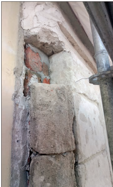
12. Wyprowadzanie gzymsu, fot. M. Jańczuk
