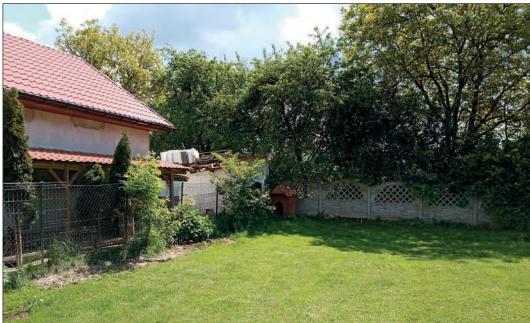
Fot. 28 Lublin – Majdan Wrotkowski, gm. Lublin, Stan. 10. Widok na fragment uszkodzonego (zniwelowanego) nasypu największego kopca w obrębie przydomowego ogrodu (fot. G. Mączka).
