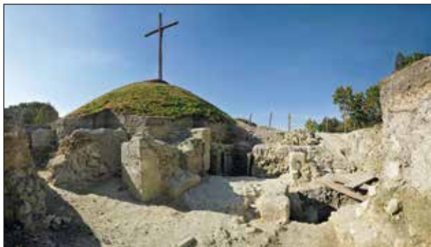
Fot. 3. Chełm. Mury budowli A1 z ciosów piaskowca zielonego – widok ogólny (fot. G. Zabłocki)
