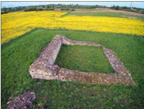
Fot. 2. Stan zachowania ruin wieży w Bielawinie w dniu 10.05.2019 roku. Widok w kierunku wschodnim. Fot. P. Bakun
