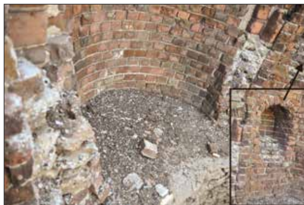
Fot. 2. Stołpie. Zniszczenia wschodniej kaplicy z apsydą i niszą spowodowane przez ptaki (fot. S. Gołub)
