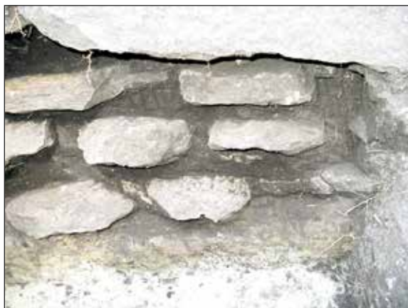
Fot. 3. Stołpie. Wykop 33. Kamiennie – ziemny fundament wieży (fot. M. Auch)
