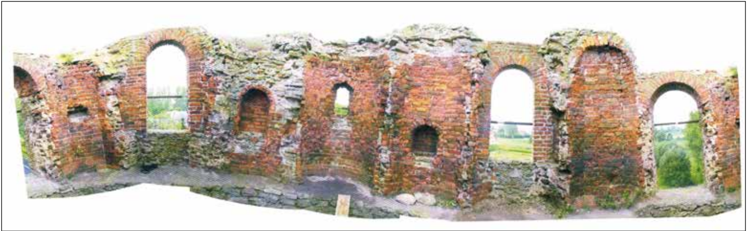
Fot. 7. Stolpie. Kaplica na ostatniej kondygnacji wieży – widok panoramiczny (fot. i oprac. M. Auch)
