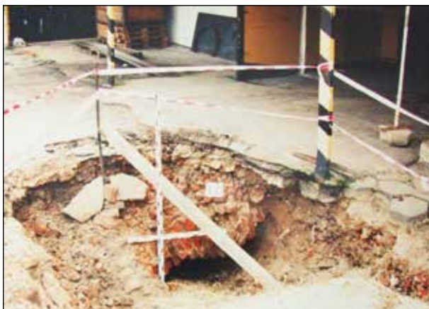
Fot. 3. Widok ogólny fragmentu sklepienia kazamat koszar obronnych (fot. E. Mitrus)
