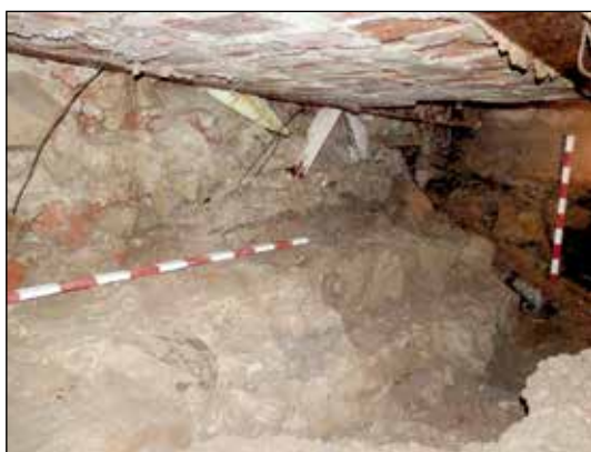
Fot. 6. Brama Grodzka – fundament przedbramia od strony kamienicy Grodzka 36 (fot. J. Tkaczyk)
