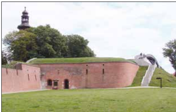
Fot. 5. Prawy bark Bastionu I z wejściem do kazamaty: A – w 1921 r. (J. Bułhak 1921), B – podczas prac w 2008 r. (J. Kuśnierz 2008), C – stan po rekonstrukcji (J. Kuśnierz 2016)
