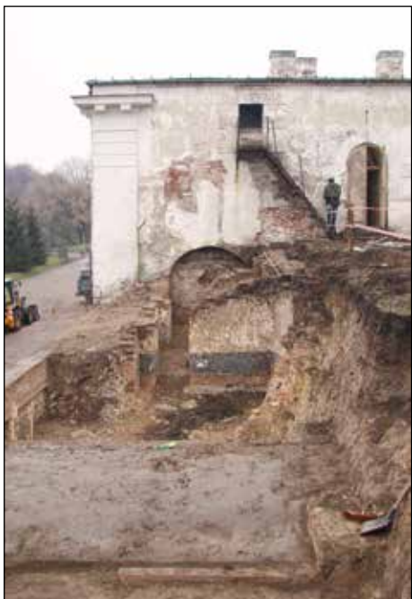
Fot. 16. Pozostałości galerii strzelniczej z widocznym, poziomym pasem malowania (tzw. brudnikiem) w kolorze granatowym. W głębi budynek Bramy Szczepieszkiej (fot. J. Kuśnierz 2009)
