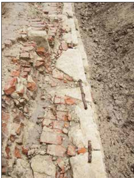
Fot. 3. Konstrukcja fundamentów Bastionu II. Widoczne klamry żelazne spinające bloki kamienia (fot. J. Kuśnierz)
