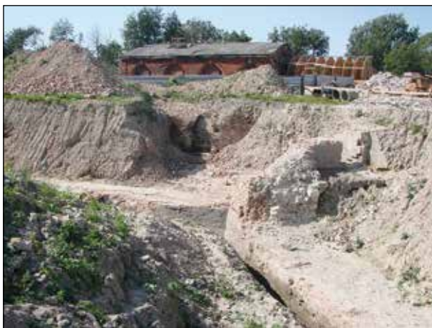
Fot. 27. Połączenie kurtyny II-III z lewym barkiem bastionu III. Po prawej stronie widoczne pozostałości przejścia z galerii strzelniczej kurtyny do lewej kazamaty bastionu III. W centrum tylna ściana kazamaty z paleniskiem, a powyżej budynek prochowni w szyi bastionu (fot. J. Kuśnierz 2011)
