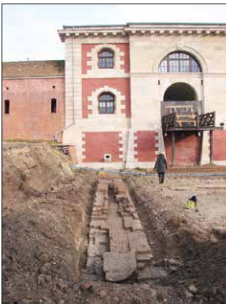
Fot. 19. Kanał odprowadzający wodę ściekową z rzygacza Bramy Szczepieszkiej do fosy (fot. J. Kuśnierz 2011)
