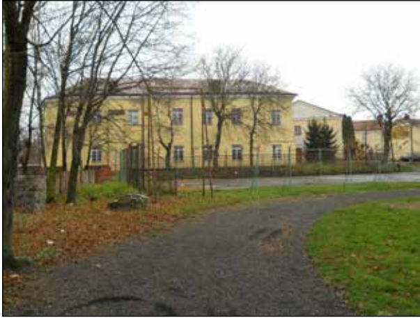
Fot. 11 Widok od północnego-zachodu na pozbawiony wskutek licznych przebudowań cech stylowych, pierwotnie gotycki, dawny kościół pw. Świętej Trójcy, który miał charakter obronny i włączony był tuż przy zamku w system średnio-wiecznych umocnień miejskich. Fot. W. Mazurek.
