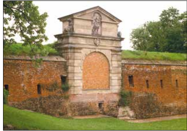
Fot. 35. Brama Lubelska Stara po renowacji – widok ok. 1995 r. (fot. H. Szkutnik)
