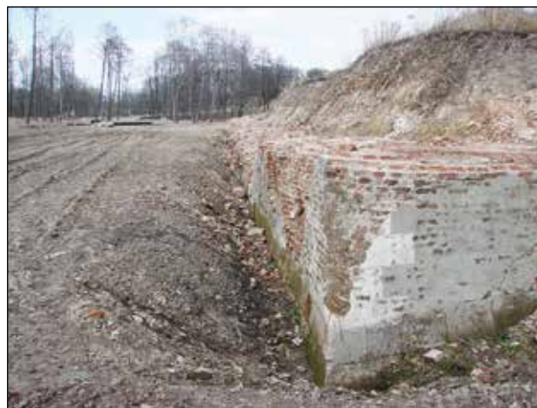
Fot. 26. Szpic bastionu III z malowaniem imitującym bloki kamienne (fot. J. Kuśnierz 2012)
