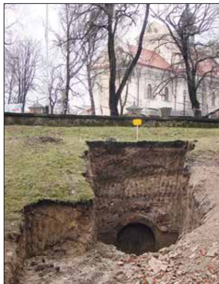
Fot. 37. Wnęką muru Carnota przed lewym czołem bastionu V (fot. J. Kuśnierz 2009).
