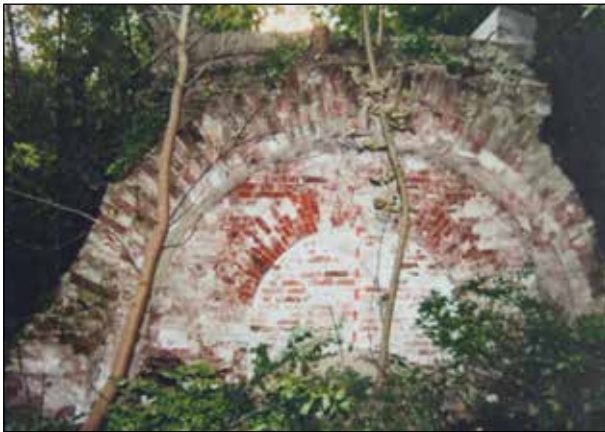
Fot. 7. Widok ogólny zachowanej naziemnej części poterny (fot. J. Tkaczyk)
