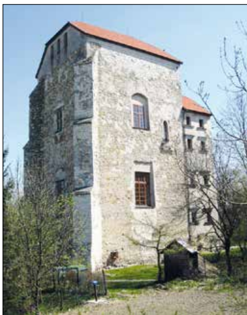
Fot. 6. Widok wieży w Wojciechowie od strony południowej (fot. J. Studziński)
