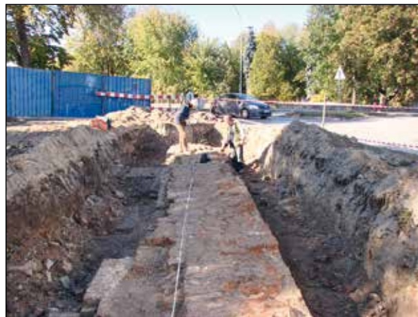
Fot. 38. Odsłonięty fragment prawego czoła bastionu V (fot. J. Kuśnierz). W głębi Park Miejski, gdzie odkryto fragment muru Carnota widoczny na ryc. 34.
