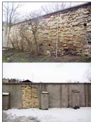
Fot. 9. Mur zachodni ogrodzenia klasztoru karmelitanek, lico zewnętrzne i wewnętrzne (fot. J. Tkaczyk)
