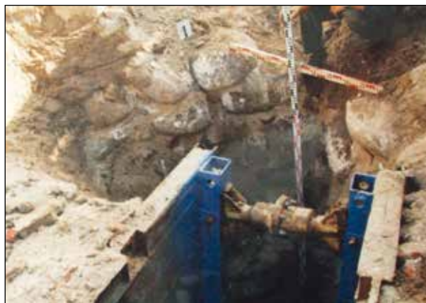
Fot. 2. Widok ogólny fundamentu kaponiery (fot. E. Mitrus)
