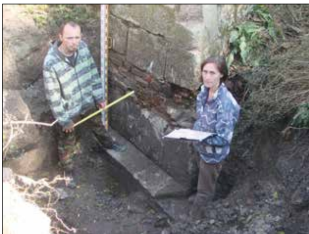
Fot. 25. Szpic Bastionu III podczas badań (na zdjęciu archeologdy Andrzej Maziarz i Klaudia Badzińska). Widoczny pas cegieł oddzielający warstwy kamiennych bloków stanowiących fundament bastionu. Fot. J. Kuśnierz 2012.
