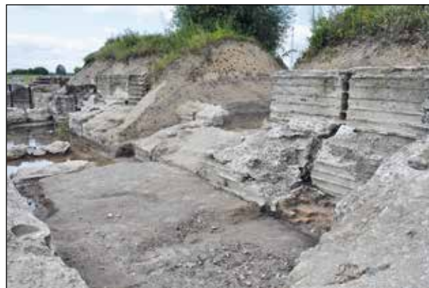
Fot. 11. Kobylany – punkt oporu Placówka – widok na odsłoniętą część schronu z przekrojem wału osłonowego (fot. M. Bienia)
