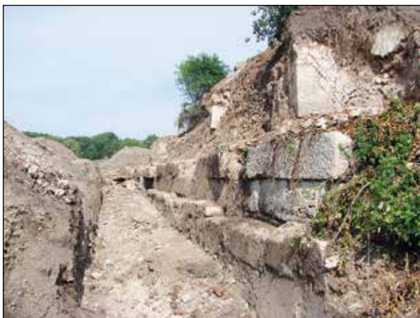
Fot. 12. Przyziemie lewego czoła bastionu II. Kamienne bloki fundamentu oraz pozostałości ceglanych murów galerii strzelniczej (Fot. J. Kuśnierz 2011)
