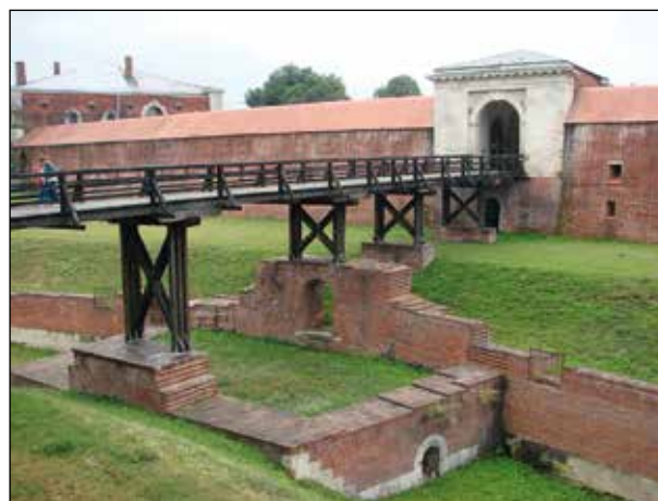
Fot. 40. Brama Lubelska Nowa po badaniach archeologicznych i rekonstrukcji. Na pierwszym planie pozostałości kojca z odchodzącym w prawo odcinkiem muru Carnota (Fot. J. Kuśnierz 2017).
