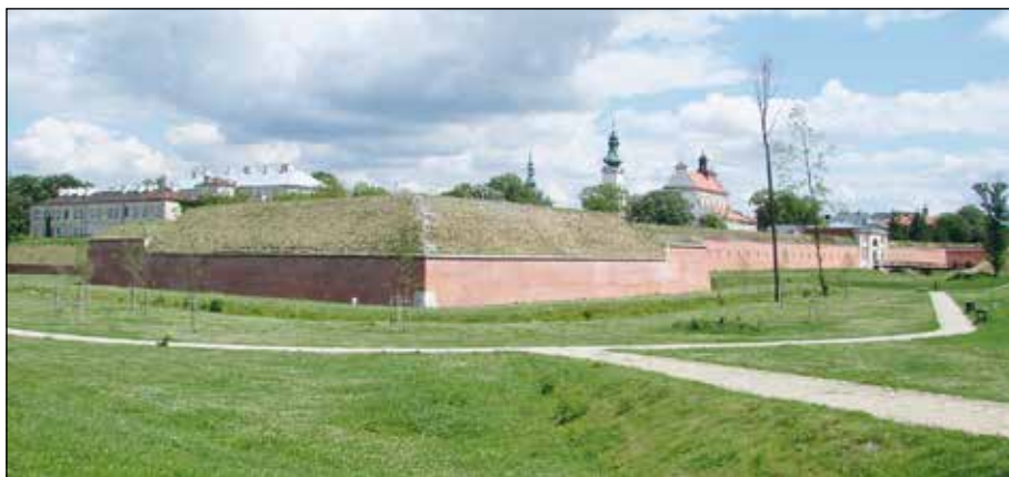
Fot. 23. Zrekonstruowany w latach 2011-2014 Bastion III w Zamościu. (Fot. H. Szkutnik).
