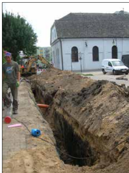
Fot. 17 Włodawa, ul. Witosa, przekrój szerokiego zagłębienia w profilu zachodnim wykopu pod wodociąg, będącego prawdopodobnie zasypiskiem fosy jako elementu umocnień miejskich. Fot. T. Mazurek.
