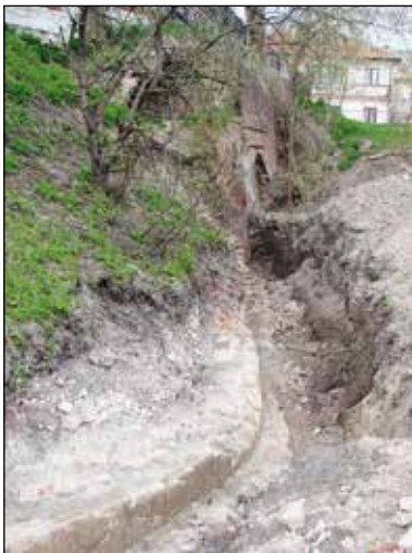
Fot. 11. Lewy bark bastionu II. W głębi widoczny mur i strzelnica lewej kazamaty bastionu. (Fot. J. Kuśnierz 2009).
