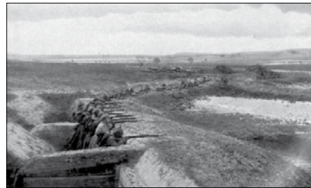
Fot. 7 Pierwszowojenny rów strzelecki z widocznymi poprzecznicami (źródło: http://wiazowna.cms-reg2.maxus.com.pl/571-UfortyfikowanyOdcinekWizowna1920.htm#okop1915 )
