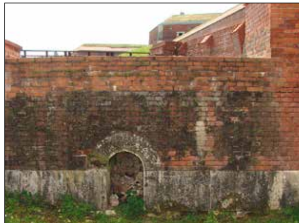
Fot. 47. Mury kojca przed kurtyną VI-VII. Stan obecny (Fot. J. Kuśnierz 2017)
