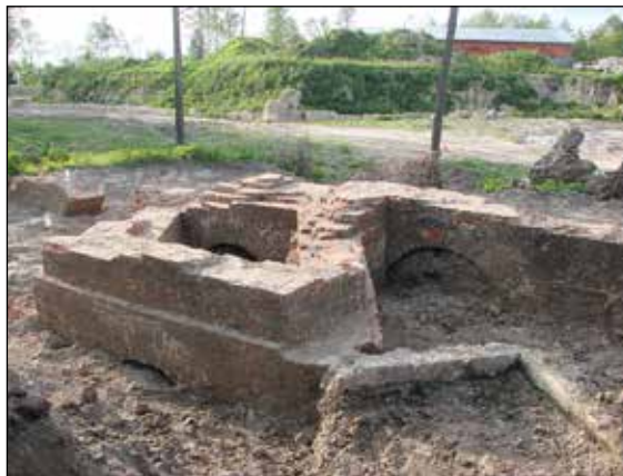
Fot. 21. Ceglane łuki przepustu wodnego i mury podpierające prawe ramię ziemnego rawelinu broniącego dojścia do Bramy Szczeczerskiej. W tle widoczny lewy bark Bastionu III i budynek Prochowni (fot. J. Kuśnierz 2012).
