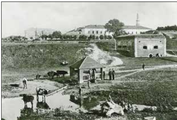
Fot. 31. Kojec przed Bramą Lubelską Starą i kurtyną IV-V około 1900 r. (fot. J. Strzyżowski). Po prawej, zasłonięta przez kojec, znajduje się Brama Lubelska Stara. Ziemia skarpa za budynkiem Kojca kryje relikty Furty Janowickiej i lewego czoła Bastionu V.
