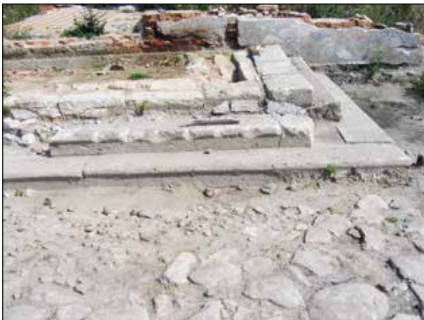
Fot. 12. Folwark w Hrebennym – na pierwszym planie bruk kamienny, na drugim – schody do dworu, na trzecim – terakotowa posadzka pomieszczenia na parterze (fot. S. Żórawski)
