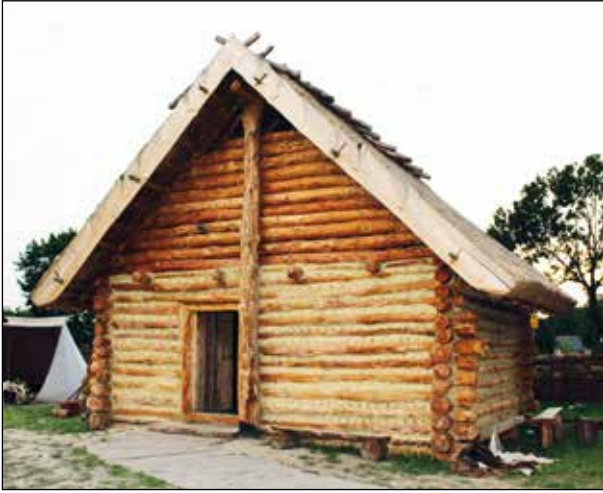
Fot. 3. Rekonstrukcja budynku z okresu rzymskiego z dachem o konstrukcji ślemieniowo-sochowej. Fot. M. Stasiak-Cyran
