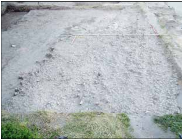
Fot. 9. Widok na nawierzchnię kamiennej drogi z wyżłobionymi koleinami – folwark w Hrebennym (fot. D. Bednarski)
