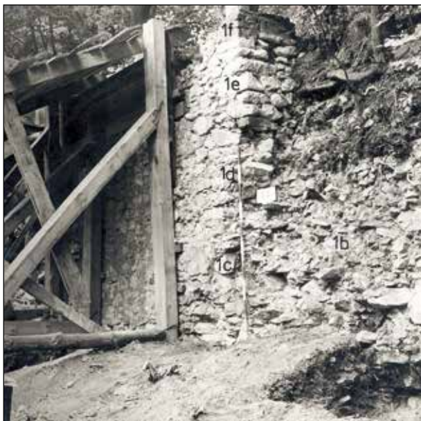
Fot. 3. Janowiec-zamek. Wschodni przyczółek mostu. Fot. A. Hunicz, 1979
