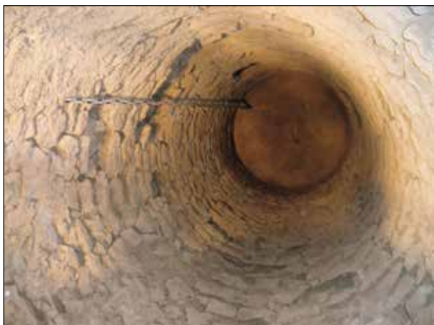
Fot. 5. Dolna partia wieży cylindrycznej po wybraniu zasypki, fot. M. Matyaszewski
