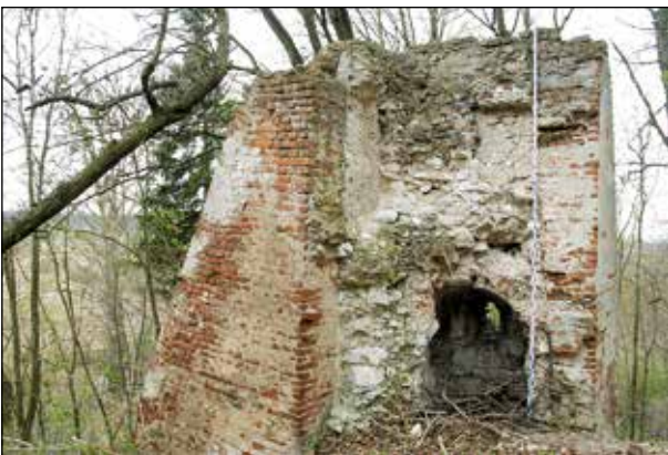
Fot. 8. Bastion pd.-zach. od wewnątrz ze śladami rozbudowy i małą kazamatą z okienkiem (fot. S. Gołub)
