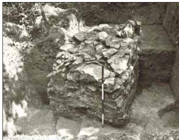
Fot. 5. Szczebrzeszyn, Wzgórze Zamkowe. Fundament drewniano-kamiennego częstokołu/parkanu odkryty w trakcie badań przeprowadzonych w latach 60-tych XX w. (autor nieznany, archiwum WUOZ w Zamościu)
