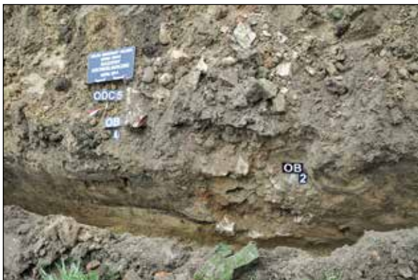
Fot. 13. Odcinek 5. Fundamenty muru z opoki i fragmentów cegieł (ob. 2) oraz nieokreślonej konstrukcji (ob. 4) (fot. S. Gołub)
