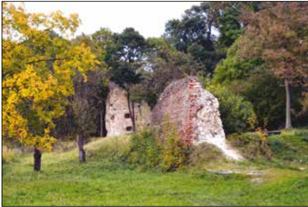
Fot. 7. Widok na ruiny zamku w Krupem od zachodu. Na pierwszym planie część zachowanej kurtyny, na drugim planie fragment bastii wschodniej. Stan obecny (fot. K. Grochecki)
