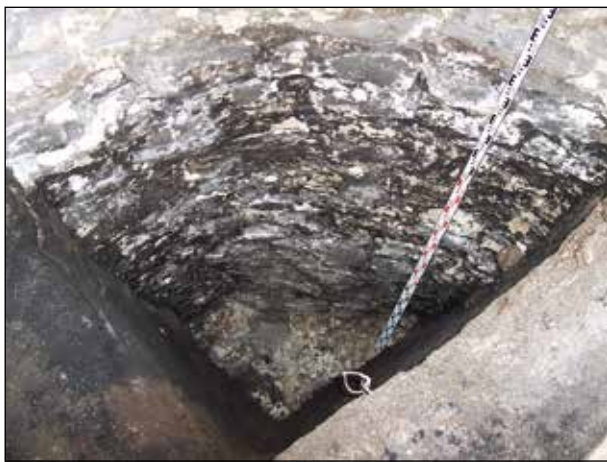
Fot. 13. Wnętrze wieży. Widok wylewki wapiennej i kamienna ściana budowli (fot. T. Dzieńkowski)
