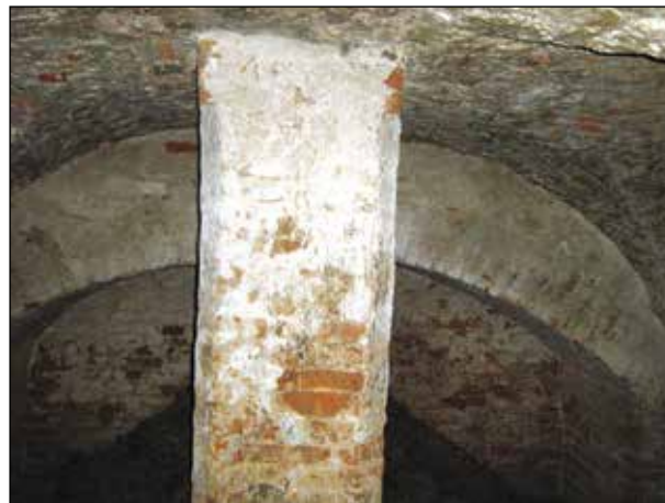
Fot. 2. Woźuczyn, pow. Tomaszów Lubelski. Piwnica zamkowa z filarem podtrzymującym sklepienie kolebkowe (fot. B. Typek)
