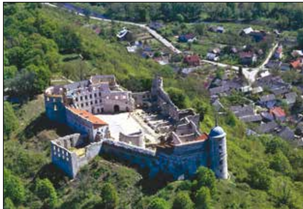
Fot. 2. Janowiec. Widok z lotu ptaka. Fot. P. Maciuk
