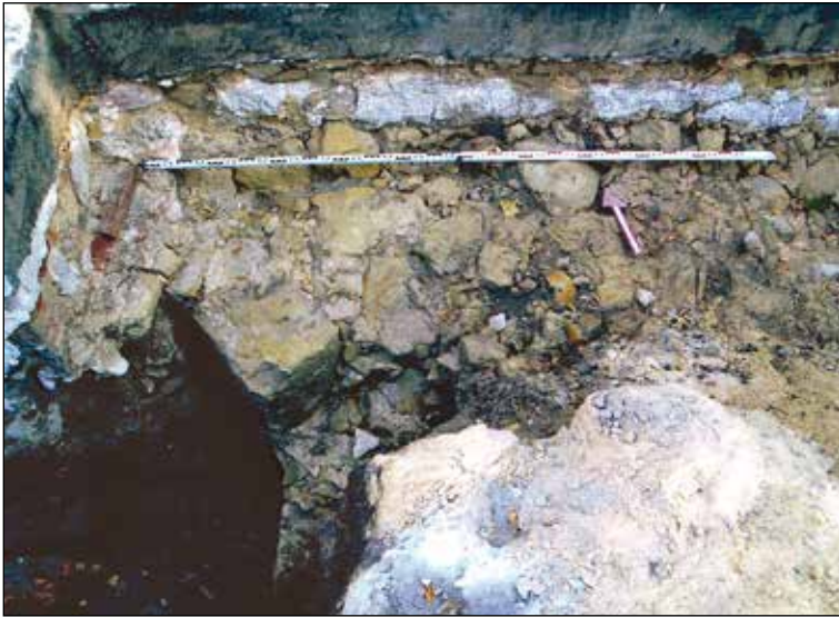
Fot. 3. Wąwolnica, Wzgórze Kościelne. Zwieńczenie górnej partii stropu korytarza nad przejściem w południowej ścianie dolnej/piwnicznej kondygnacja obecnej kaplicy Matki Boskiej Kębelskiej według J. Józwiak 2013, fot. 38.
