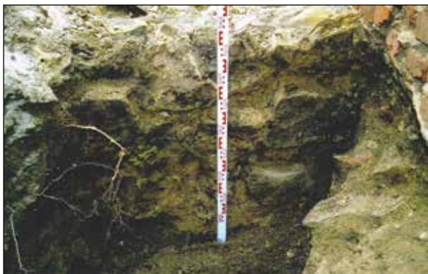
Fot. 5. Wąwolnica, Wzgórze Kościelne. Lico południowego muru obwodowego zamku królewskiego. Ujęcie od strony wschodniej według J. Józwiak 2013, fot. 35.
