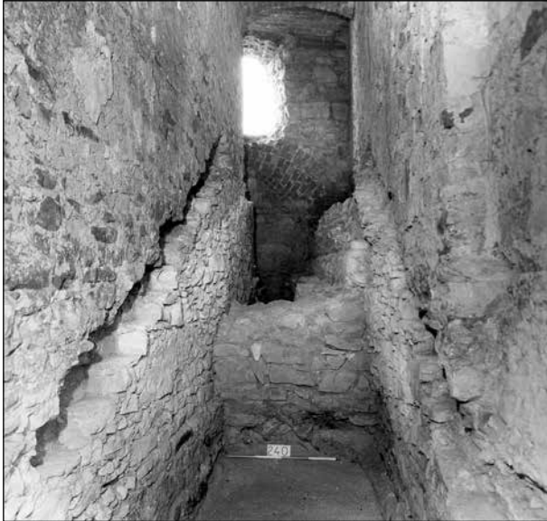
Fot. 5. Janowiec-zamek. Skrzydło wschodnie, relikty murów wewnętrznej drogi wałowej (faza I). Fot. P. Maliszewski, 1983
