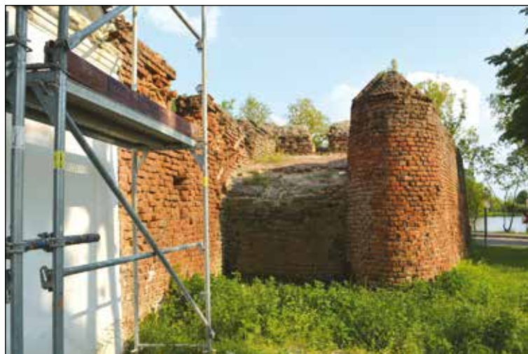
Fot. 12. Czemierniki, bastion południowo-zachodni z widocznym sklepieniem kazamat, fot. autora
