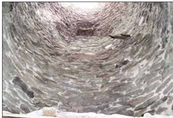
Fot. 2. Wnętrze wieży (T. Dzieńkowski)
