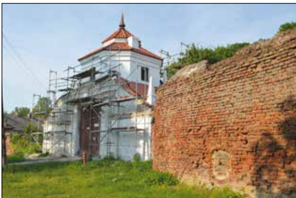
Fot. 9. Czemierniki, wieża bramna z widocznym fragmentem bastionu południowo-zachodniego, fot. autor
