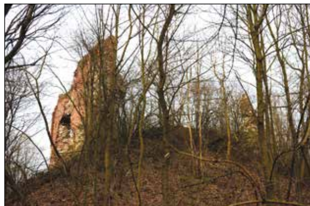
Fot. 3. Widok na ścianę południową i fragment wschodniego muru zamku w Bochothnicy. Fot. M. Kurczewicz
