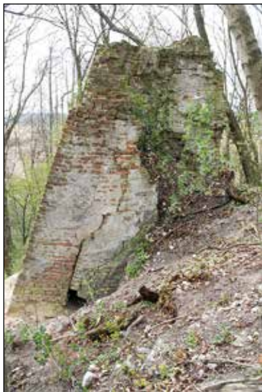
Fot. 6. Bastion pd.-wsch. od wewnątrz ze śladami rozbudowy (fot. S. Gołub)
