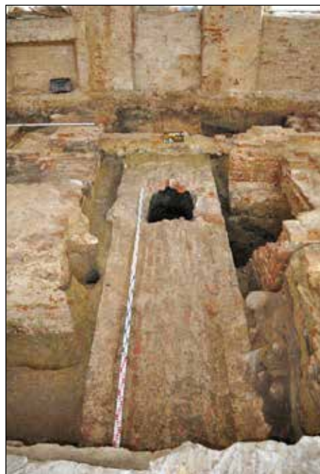
Fot. 25. XVIII-wieczny pawilon zachodni z odsłoniętymi reliktnami wieży bramnej z XVI/XVII wieku, pod którą biegł murowany kanał odprowadzający wodę deszczową z dziedzińca (fot. M. Bienia)
