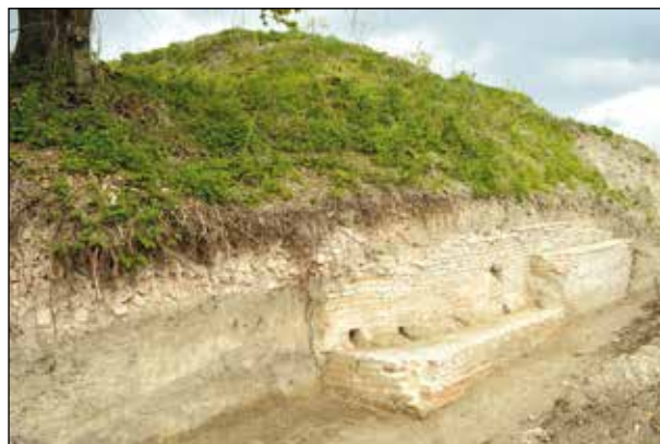
Fot. 6. Kryłów, gm. Mircze. Bastion wschodni. Widok od południa, od strony rzeki Bug na zakończenie czoła południowo-wschodniego. Na fotografii ukazane otwory po drewnianych belkach (fot. M. Piotrowski)
