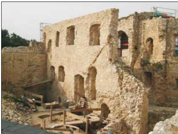
Fot. 8. Dom Wielki w czasie prac badawczych i konserwatorskich, fot. M. Matyaszewski
