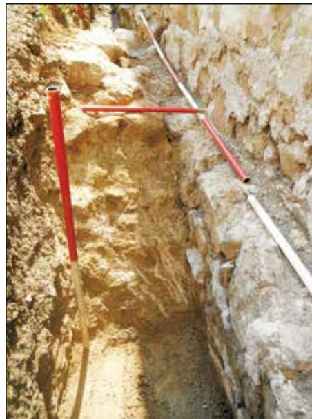
Fot. 6. Wkopany w skałę fundament północnego odcinka zachodniego muru obwodowego, ponad ławą widoczne odciski desek po naprawie K. Sicińskiego w latach 1947–1958, widok od północy, fot. E. Mitrus
