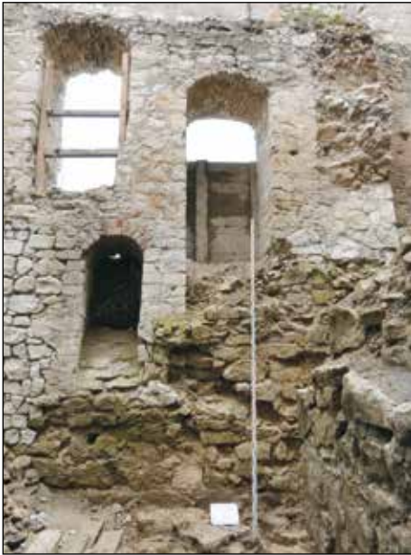
Fot. 13. Środkowy odcinek północnej ściany Domu Wielkiego, widok od południa, wykop 14, fot. J. Józwiak
