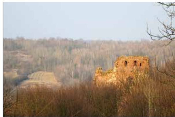
Fot. 1. Ruiny zamku w Bochothnicy – widok z wysoczyzny od strony południowo wschodniej. Fot. M. Kurczewicz
