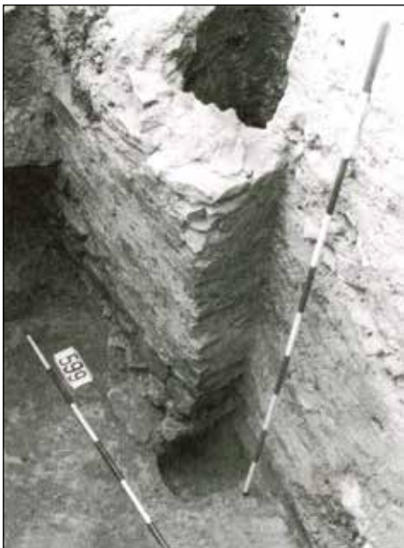
Fot. 7. Janowiec-zamek. Narożnik kamiennej podstawy drewnianej wieży słupowej (faza I), fot. A. Hunicz 1994
