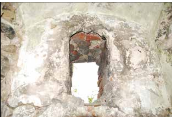
Fot. 9. Widok otynkowanej kazamaty w bastionie pd.-zach. w części górnej (fot. S. Gołub)
