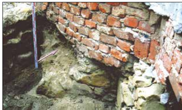
Fot. 4. Wąwolnica, Wzgórze Kościelne. Fragment fundamentu południowo-wschodniej części kaplicy z widocznym reliktem dwudzielnego otworu strzelniczego według J. Józwiak 2013, fot. 33.
