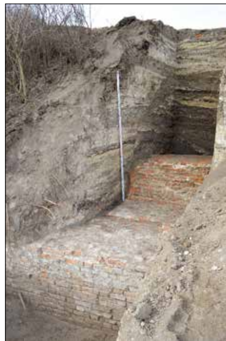
Fot. 4. Kryłów, gm. Mircze. Bastion wschodni. Wykop 3/2014. Ujęcie od wschodu, od strony rzeki Bug. Widoczne nawarstwienia ziemnego nasypu bastionu i lokalizację muru ceglanoego czoła południowo-wschodniego z wyraźnymi śladami rozbierania (fot. M. Piotrowski)
