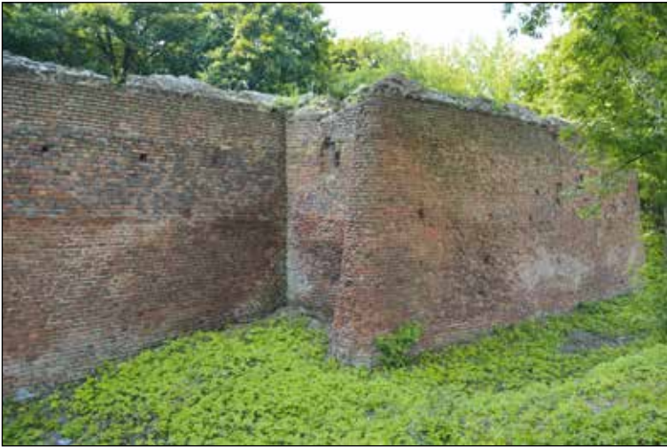
Fot. 10. Czemierniki, bastion wraz z fragmentem muru kurtynowego, fot. autora
