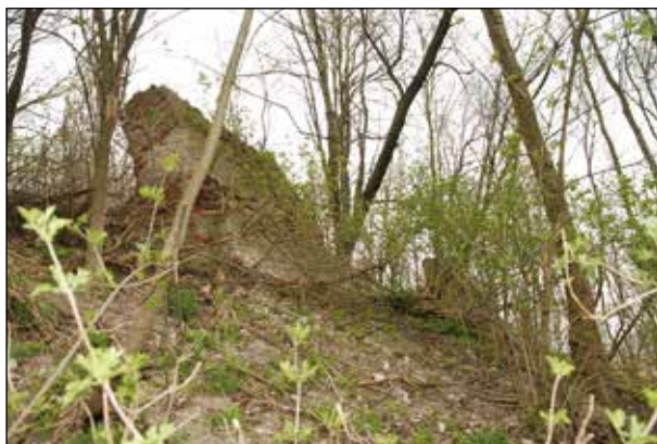
Fot. 11. Relikt muru z cegieł między bastionami (fot. S. Gołub)
