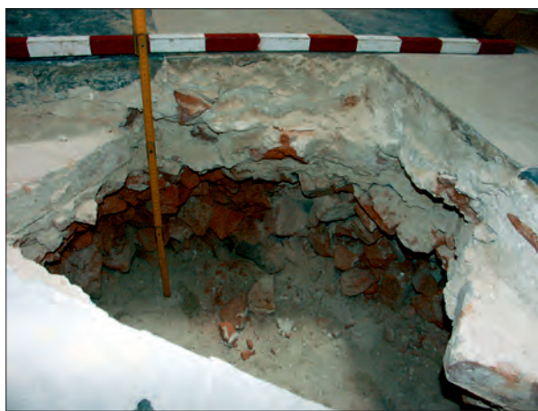
Fot. 13. Przekrój przez warstwy konstrukcyjne posadzki w jednym z sondaży z 2006 r. (fot. R. Niedźwiadek)
