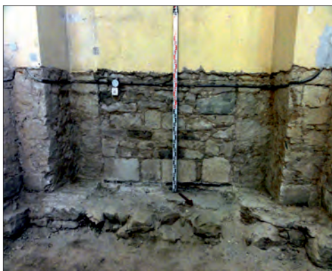
Fot. 4. Zamurowanie dawnego bocznego wejścia do kościoła od strony południowej, ujawnione po skuciu tynku (fot. J. Józwiak).
