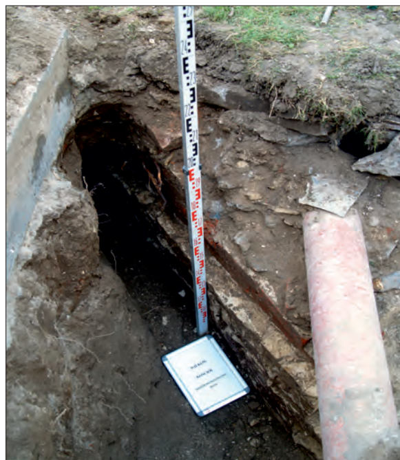
Fot. 7. Fragment północnej ściany prezbiterium niezrealizowanego kościoła, widoczna kamienna ława i dolna partia ceglanej ściany, 1908 r. (fot. M. Matyszewski)
