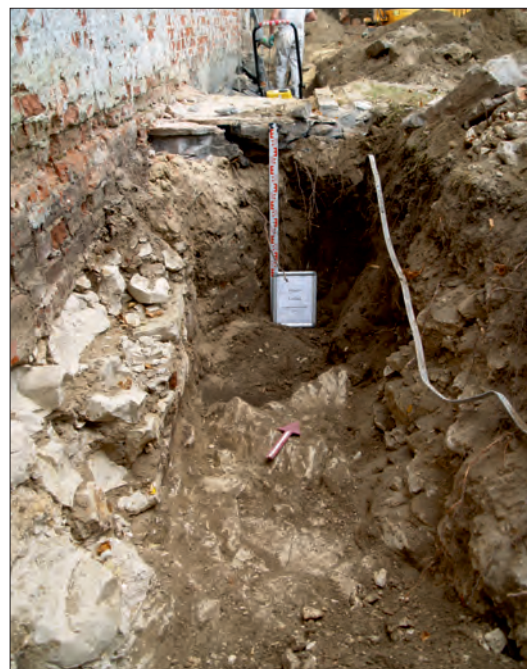
Fot. 3. Wzmocnienie fundamentu? po północnej stronie nawy, po 1625 roku (fot. J. Józwiak).
