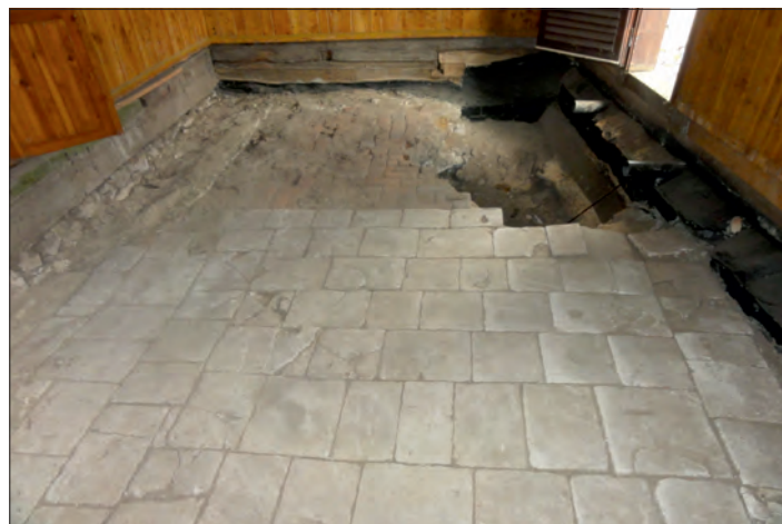
Fot. 19. Posadzka wykonana z kamieni wapiennych oraz cegieł odłożona w zakrystii (fot. D. Włodarczyk).
