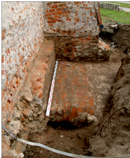
Fot. 9. Ceglane „sklepienie” przekrywające przestrzeń między prezbiterium obecnego kościoła i fundamentem niezrealizowanego kościoła z 1908 r. (fot. J. Józwiak)
