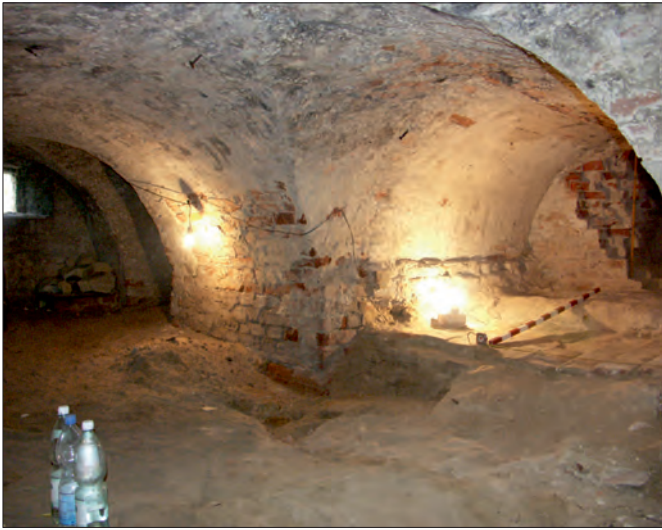
Fot. 15. Odgałęzienie podziemnych korytarzy pod przedsionkiem kościoła (fot. R. Niedźwiadek).
