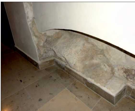
Fot. 11. Relikt „gotyckiego” sklepienia eksponowany w obrębie wschodniej ściany południowego pomieszczenia piwnicznego d. szpitala (fot. M. Matyaszewski).
