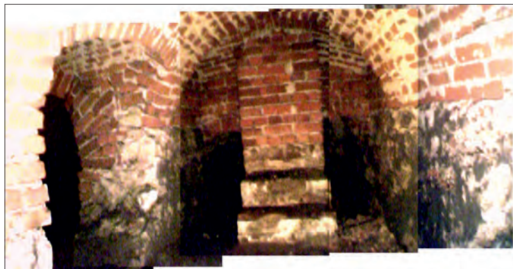
Fot. 2. Fragment podziemnych pomieszczeń. Zestawienie obrazów z mini-kamery (fot. W. Nawrocki, W. Antosiewicz, J. Pieczonka).
