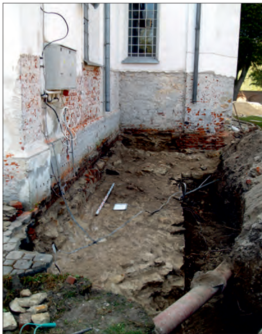
Fot. 4. Ława niezrealizowanego kościoła po północnej stronie zakrystii, 1908 r. (fot. J. Józwiak)
