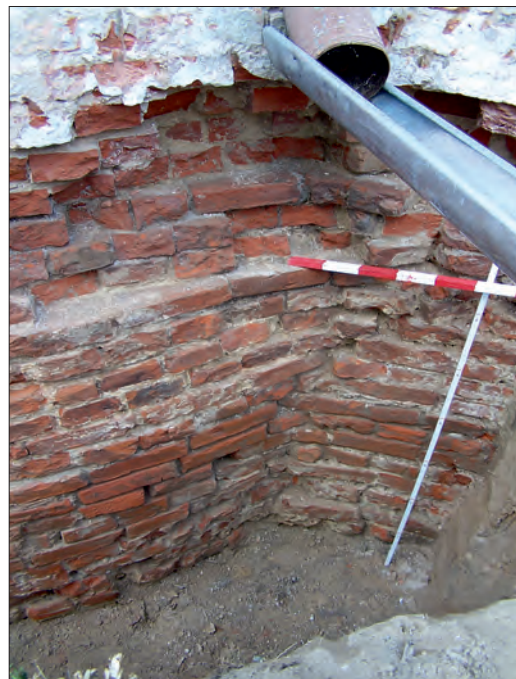
Fot. 6. Przewiązane ze sobą mury fundamentowe korpusu kościoła i przedsionka (fot. R. Niedźwiadek).
