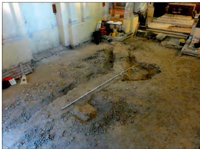
Fot. 2. Relikty kaplicy Św. Ducha odsłonięte w trakcie wymiany posadzki w kościele św. Anny. Ujęcie od str. zach. (fot. J. Józwiak).
