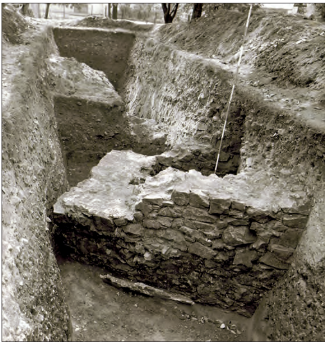
Fot. 9. Janowiec, wykop II, fundament dzwonnicy (fot. J. Cichomski).
