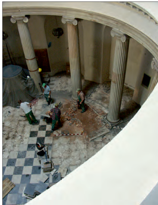
Fot. 11. Prace przy demontowaniu ołtarza (fot. R. Niedźwiadek).
