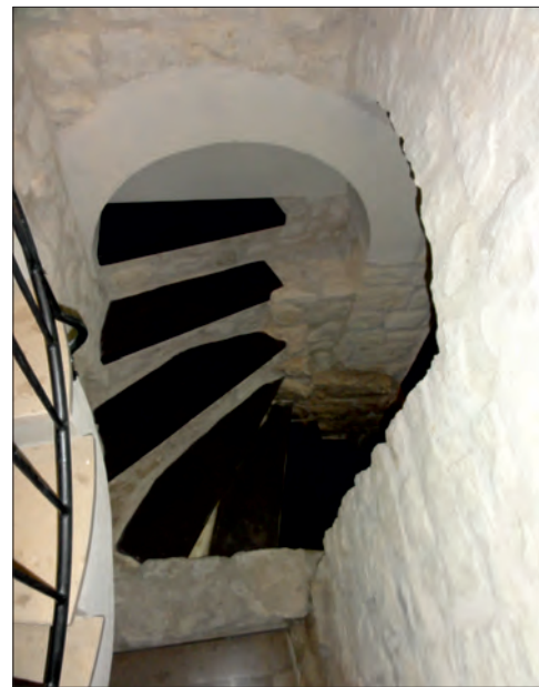
Fot. 12. Fragmentarycznie zachowane i poddane zabiegom konserwatorskim dawne schody zabiegowe prowadzące do południowego pomieszczenia piwnicznego d. budynku szpitalnego (fot. M. Matyaszewski).
