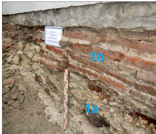
Fot. 4. Wyróżnione elementy obecnej partii fundamentowej południowo-wschodniej wieży kościelnej (mury 1a, 1b) (fot. M. Matyaszewski).
