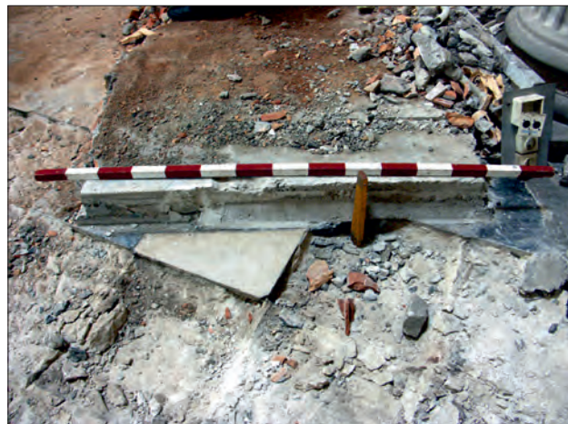
Fot. 12. Betonowa podstawa ołtarza ustawiona na marmurowych płytach posadzki (fot. R. Niedźwiadek).
