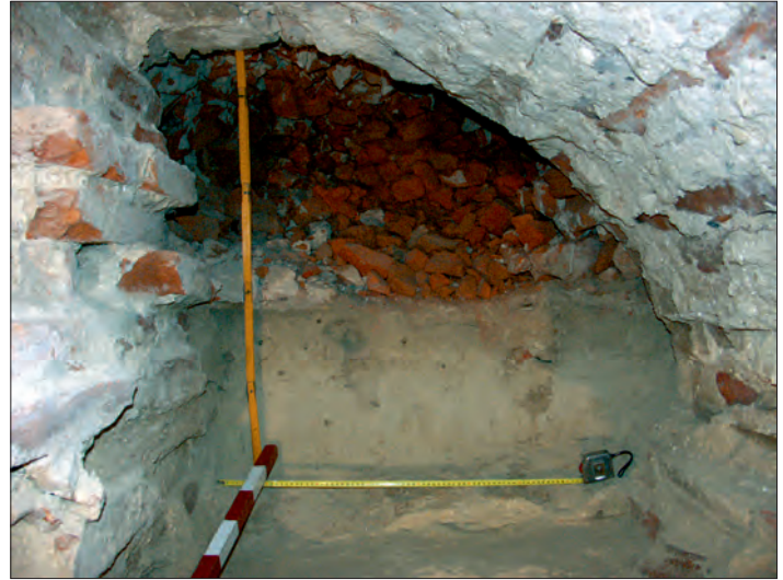
Fot. 16. Częściowo rozkute zamurowanie otworu w partii wewnętrznego fundamentowania, jakie odsłoniło warstwy konstrukcyjne posadzki (fot. R. Niedźwiadek).
