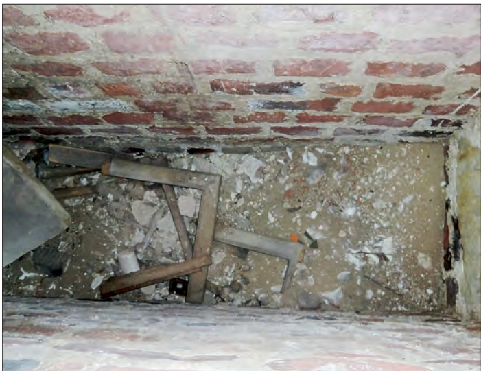
Fot. 13. Grób Piotra Strzemińczyka w kaplicy, wewnątrz po zdjęciu wapiennej płyty (fot. M. Matyaszewski).
