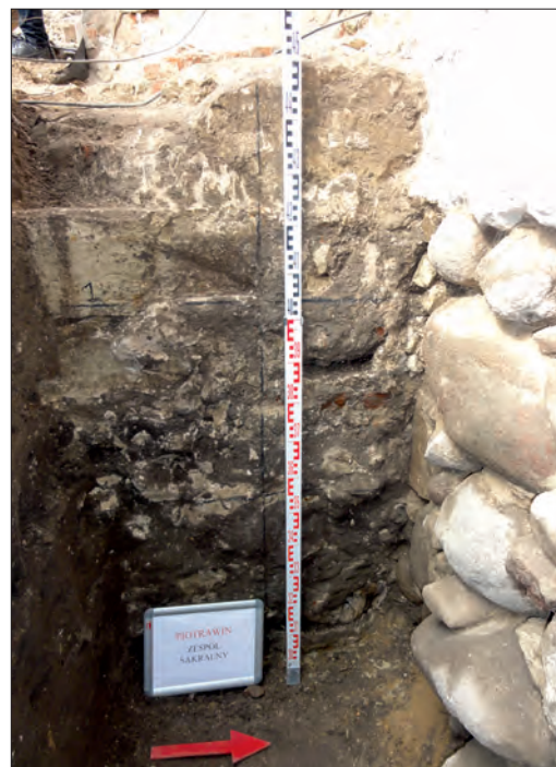
Fot. 8. Mur kolegiaty z lat 1770-1772 (po lewej) dostawiony do fundamentu gotyckiego kościoła z lat 1440-1441 (fot. M. Matyaszewski).
