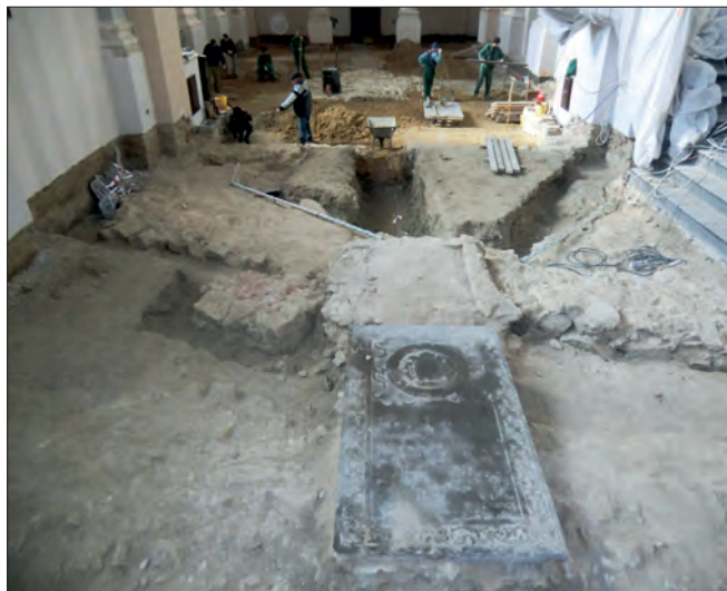
Fot. 11. Mury odkryte w prezbiterium kościoła, poprzeczny do osi fundament świątyni z lat 1561-1610 (fot. M. Matyaszewski).
