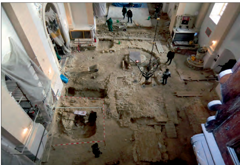
Fot. 6. Kościół w trakcie remontu i badań archeologicznych, po zdjęciu posadzki, widok z chóru (fot. M. Matyaszewski).
