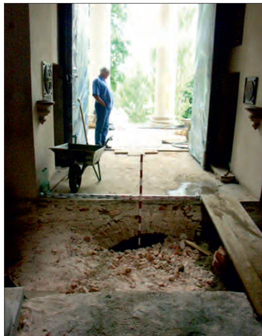
Fot. 14. Otwór w partii fundamentowej na wysokości wejścia do kościoła (fot. R. Niedźwiadek).
