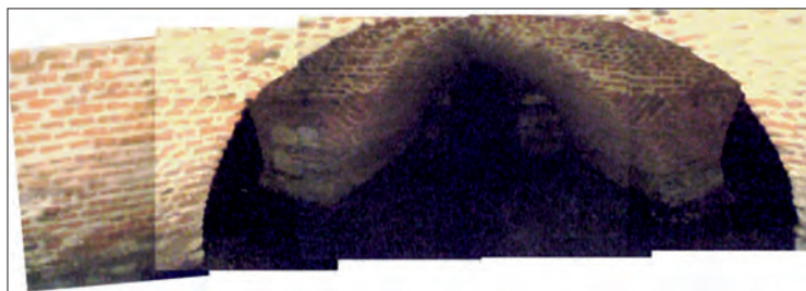
Fot. 3. Fragment podziemnych pomieszczeń. Zestawienie obrazów z mini-kamery (fot. W. Nawrocki, W. Antosiewicz, J. Pieczonka).
