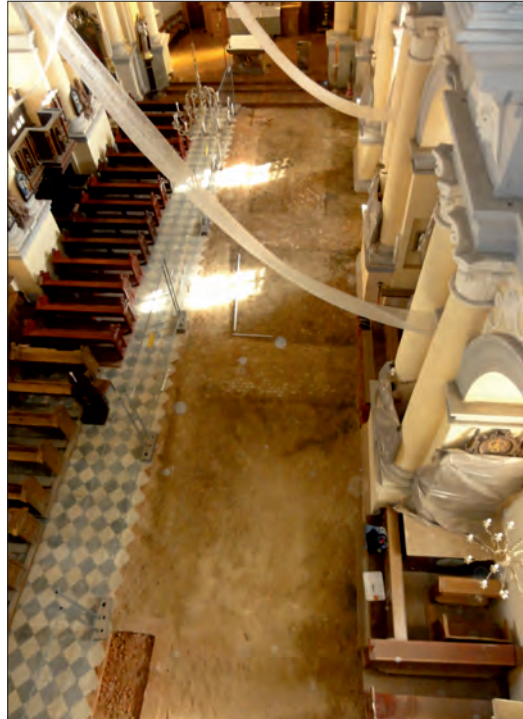
Fot. 5. Widok z góry na nawę kościoła z odsłoniętymi częściowo ceglаныmi sklepieniami krypt (część południowa) (fot. D. Włodarczyk).
