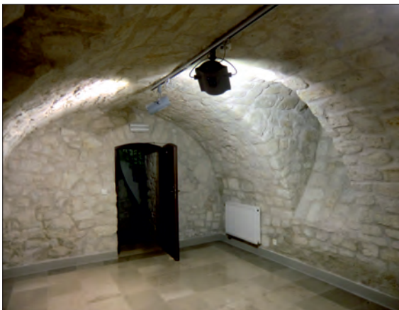
Fot. 10. Kolebkowo przesklepiona piwnica odkryta w środkowej części budynku (pomieszczenie 0.5) d. szpitala. Stan po przeprowadzeniu prac remontowo-konserwatorskich i adaptacji na potrzeby Kazimierskiego Domu Kultury (fot. M. Matyaszewski).
