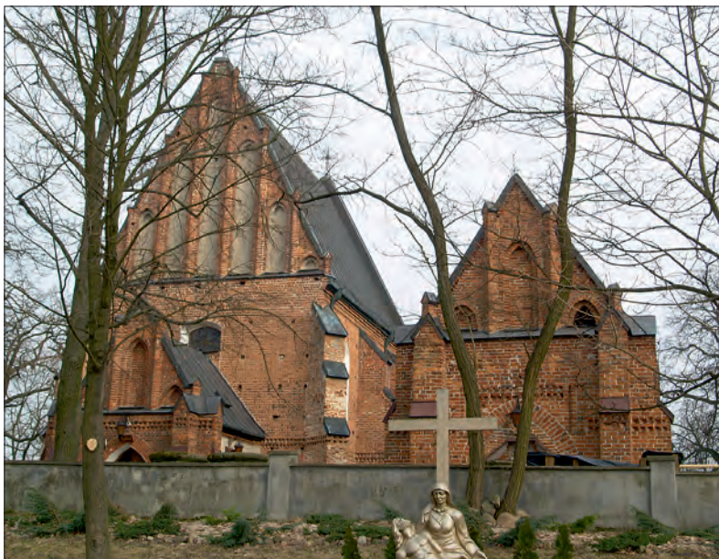
Fot. 1. Widok kościoła i kaplicy od zachodu (fot. M. Matyaszewski).
