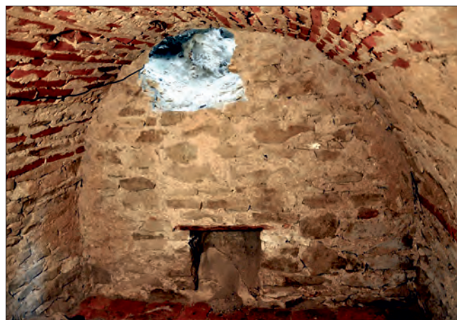
Fot. 8. Krypta 1. Ściana wsch. z fragm. posadzki i szybem wentylacyjnym (fot. S. Gołub).
