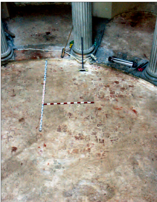
Fot. 10. Szersze ujęcie na poziom ułożony z łamanych cegieł ceramicznych (fot. R. Niedźwiadek).
