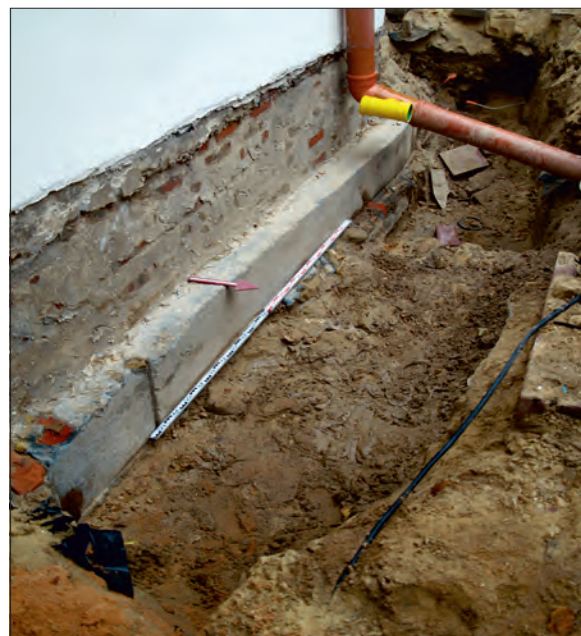
Fot. 3. Fundament pierwotnej ściany frontowej XIV w. kaplicy (fot. J. Józwiak).
