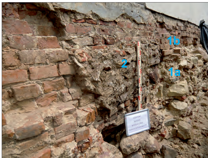
Fot. 2. Zamurowanie wlotu wentylacyjnego do krypty (mur 2), odsłonięte w obrębie obecnego południowego fundamentu nawy kościoła (mury 1a, 1b) na wysokości arkadowej wnęki ołtarzowej (fot. M. Matyaszewski).
