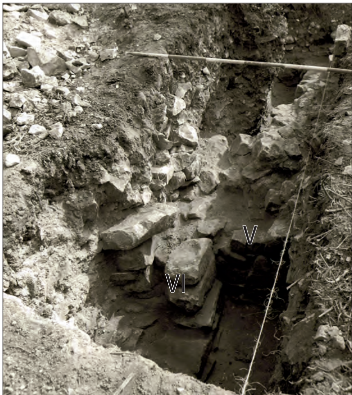
Fot. 5. Janowiec, wykop Nr V, fundamenty „łącznika” kościół-szpital. (fot. J. Cichomski).
