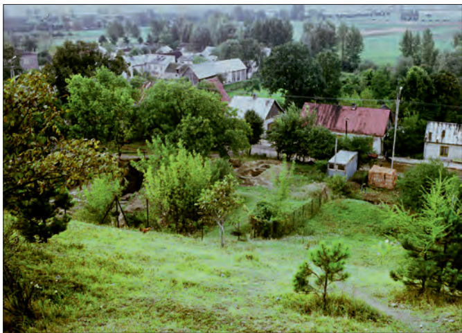
Fot. 1. Janowiec, ujęcie całościowe, widok z północnej części skarpy (fot. J. Cichomski).
