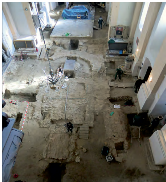
Fot. 5. Kościół w trakcie remontu i badań archeologicznych, po zdjęciu posadzki, widok z chóru (fot. M. Matyaszewski).
