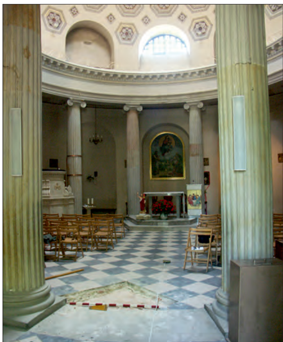
Fot. 8. Jeden z sondży poprzedzający zdjęcie posadzki w 2006 r. (fot. R. Niedźwiadek)
