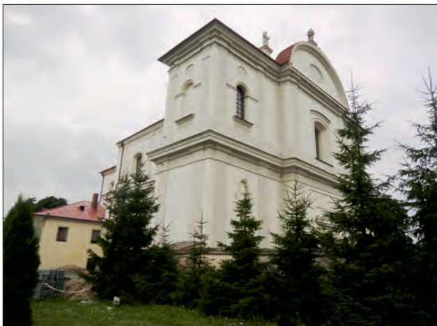
Fot. 1. Widok kościoła pw. Bożego Ciała i klasztoru w Józefowie nad Wisłą od strony południowo-wschodniej (fot. M. Matyaszewski).
