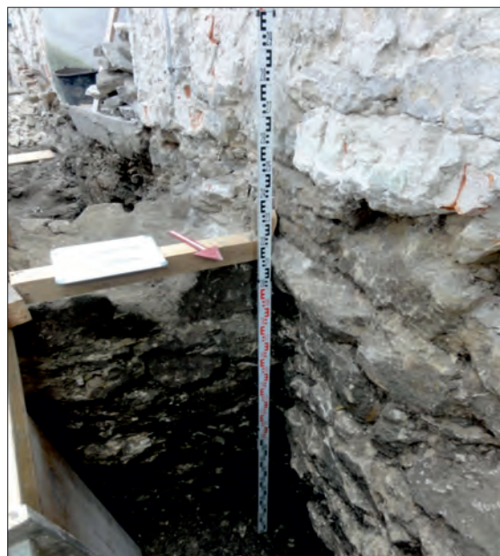
Fot. 6. Północno-zachodnie narożne kaplicy Św. Ducha, odsłonięte w trakcie prac ziemnych związanych z układaniem izolacji pionowej na licach fundamentów dawnego budynku szpitalnego (fot. M. Matyaszewski).
