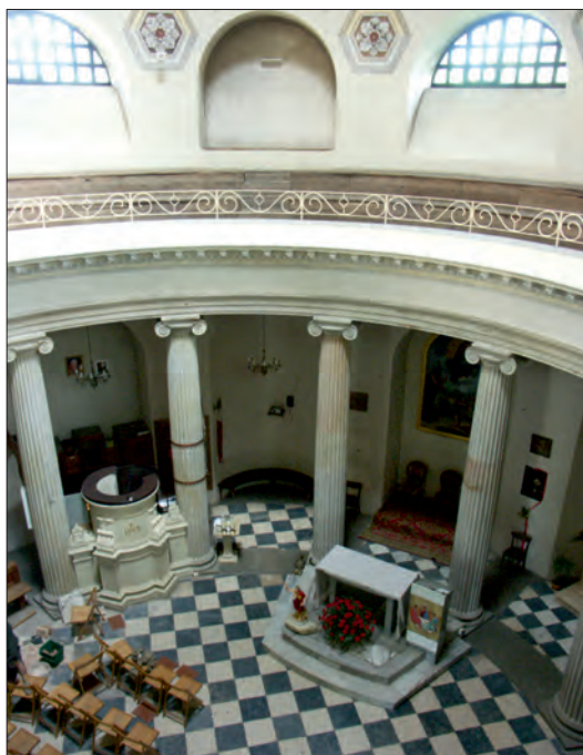
Fot. 4. Wnętrze kościoła - podstawa kopuły, empora, wewnętrzna kolumnada, ołtarz - stan sprzed wymiany posadzki w 2006 r. (fot. R. Niedźwiadek)
