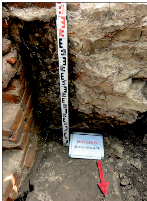
Fot. 7. Widok od północy na mury odkryte przy północno-zachodnim narożniku kaplicy z lat 1440-1441, u dołu fundament starszej kaplicy, po lewej mur obecnego obiektu, w głębi fundament kolegiaty biskupa Sołtyka z lat 1770-1772 (fot. J. Józwiak).
