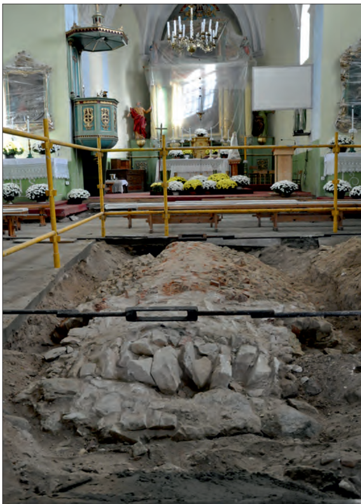
Fot. 6. Wnętrze kościoła z odczyszczonym stropem krypty nr 1 (fot. S. Gołub).
