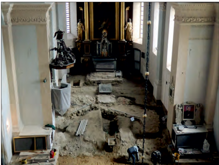
Fot. 10. Fundamenty odkryte w prezbiterium kościoła (fot. M. Matyaszewski).
