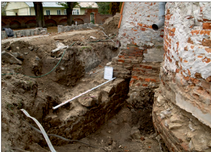
Fot. 8. Fragment fundamentu południowej ściany prezbiterium niezrealizowanego kościoła na którym wsparto część przypory obecnej świątyni, 1908 r. (fot. M. Matyaszewski)
