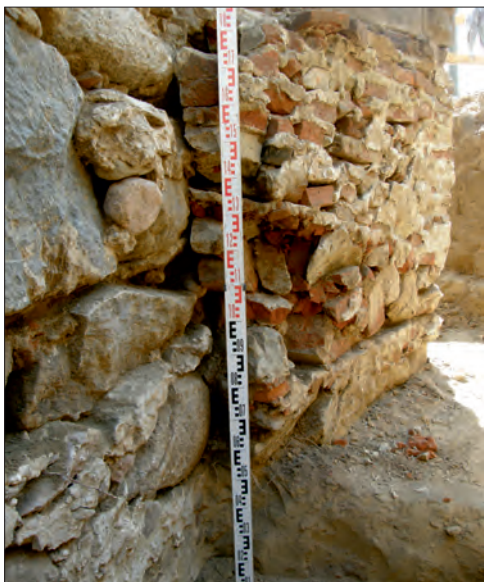
Fot. 3. Fragment fundamentu zachodniej ściany kościoła (fot. M. Matyaszewski).
