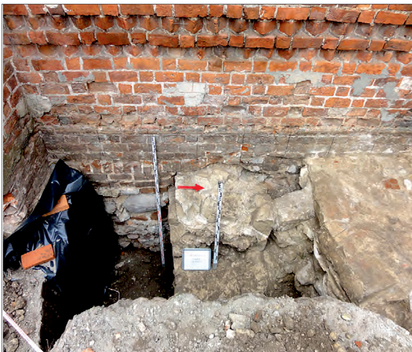
Fot. 3. Wschodnia ściana kaplicy z lat 1440-1441, w środku południowa ściana starszej kaplicy, po prawej mur kolegiaty biskupa Sołtyka z lat 1770-1772 (fot. J. Józwiak).
