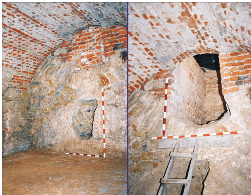
Fot. 5. Północna ściana krypty środkowej – po lewo, w ujęciu ogólnym, widoczne ślady szerokiego rozkucia; po prawo – odsłonięty otwór wejściowy z korytarzykiem prowadzącym do nawy głównej (fot. R. Niedźwiadek).
