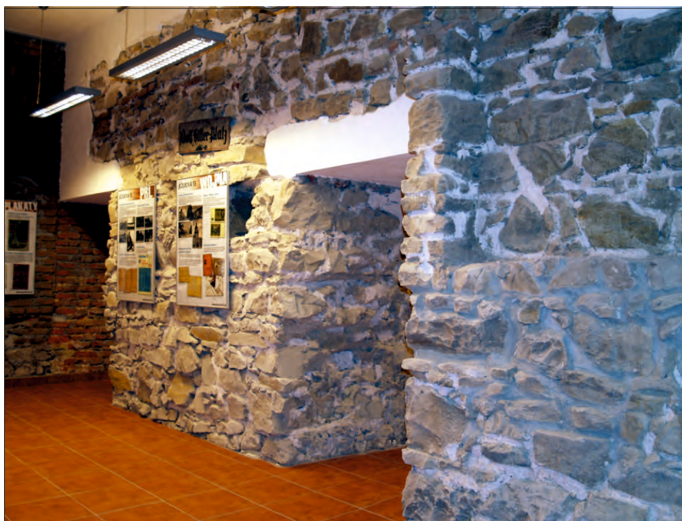
Fot. 15. Pomieszczenie Archiwum służy celom wystawienniczym z eksponowaną ścianą wewnętrzną (3c), otworami przejściowymi wykonanymi w ramach adaptacji oraz otynkowanymi fragmentami uzupełnień (fot. autor).
