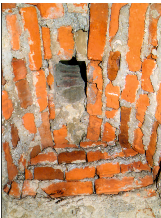
Fot. 11. Sklepienie niszy górnej kondygnacji „karceru” z wyodrębnionym otworem wentylacyjnym (fot. autor).
