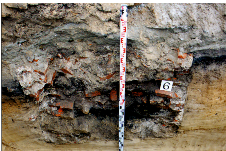
Fot. 5. Relikt kanału jezuickiego odsłonięty w świetle ul. Królewskiej na wysokości kamienicy nr 11, podczas modernizacji podziemnej infrastruktury technicznej realizowanej w 2002 roku. Ujęcie od strony południowej (fot. autor).
