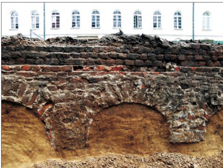
Fot. 3. Fragment fundamentu punktowego ceglanoego muru ogrodzeniowego klasztoru dominikanów (fot. D. Włodarczyk).
