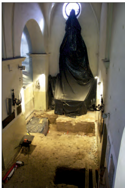
Fot. 2. Widok na nawę boczną podczas wykopalisk (fot. R. Niedźwiadek).
