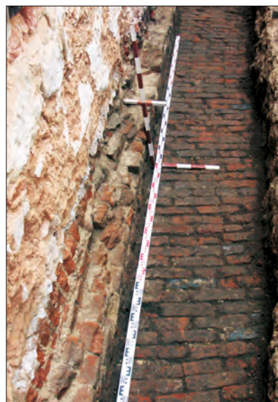
Fot. 8. Nowożytny, ceglany trotuar przed głównym wejściem do kościoła (fot. K. Drobek).
