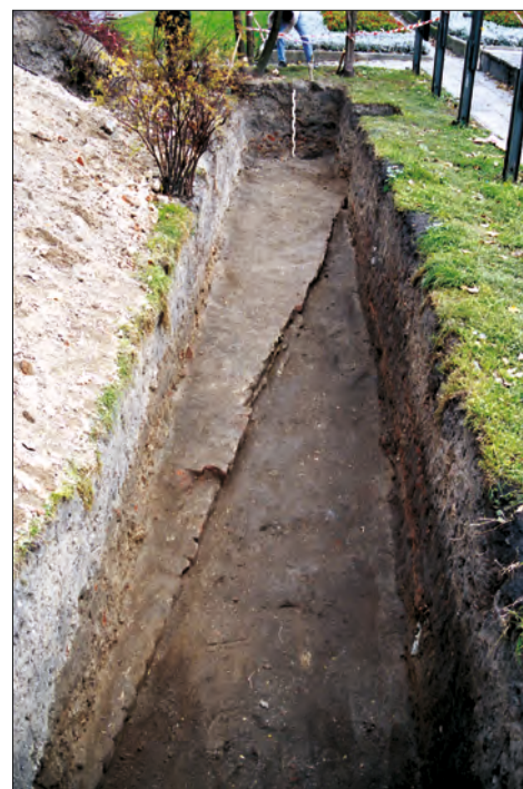
Fot. 2. Widok od zachodu na fundament północnej ściany nawy kościoła (mur 1 w wykopie I).
