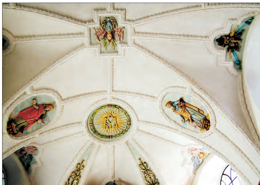
Fot. 13. Medaliony w prezbiterium kościoła – stan po zakończeniu prac konserwatorskich (fot. R. Niedźwiadek).
