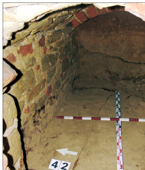
Fot. 21. Północna ściana krypty „F” wystawiona z obrabianych bloków wapiennych oraz cegły gotyckiej (fot. M. Kacprzak).
