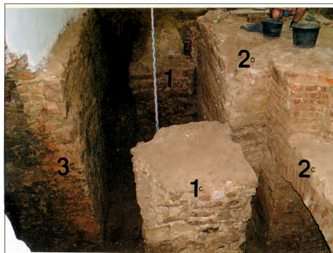
Fot. 6. Relikw murów odsłonięte w przestrzeni międzyfundamentowej (pomieszczenie 02) w trakcie prac remontowo-budowlanych prowadzonych w 2007 roku w zachodniej części budynku Archiwum Państwowego przy ul. Jezuickiej 13. Ujęcie od strony południowej (fot. autor).
