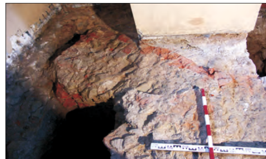
Fot. 4. Oblicowana cegłą narożna przypora najstarszej świątyni, wchłonięta przez mury nowszych faz budowlanych (fot. R. Niedźwiadek).
