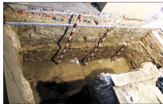
Fot. 3. Fundament południowej i zachodniej ściany kaplicy sprzed fundacji W. Jagiełły - na murze widoczna jest średniowieczna odsadzka (fot. R. Niedźwiadek).
