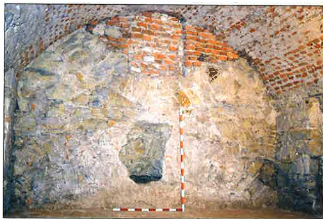
Fot. 6. Ściana zamykająca od północy „kryptę środkową”, w szczytowej jej części widoczne są przemurowania i zasklepiony otwór wejściowy (stan po zakończeniu badań). Fot. Rafał Niedźwiadek.
