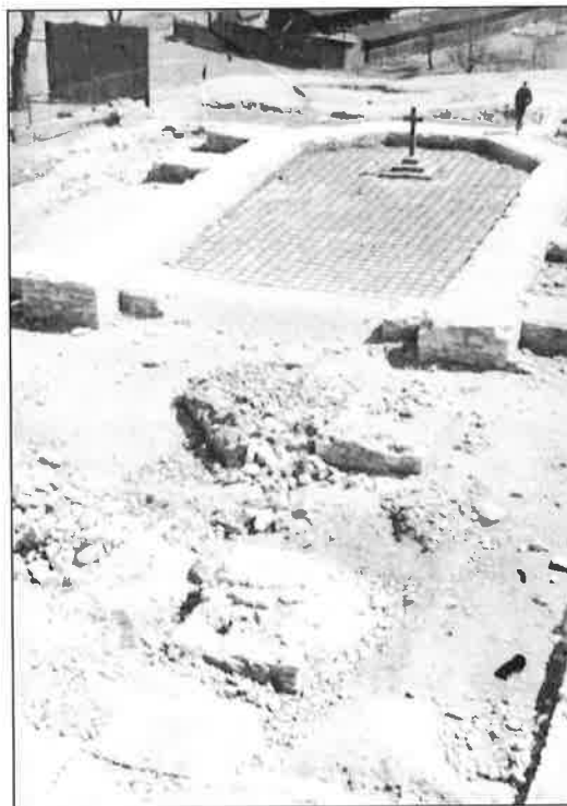
Ryc. 9. Widok od południowego-zachodu na południowo-wschodnią część nawy w ostatniej fazie rekonstrukcji i prezbiterium po rekonstrukcji z lat 1938–1939, kopia fotografii przechowywanej w Wydziale Architektury i Administracji Budowlanej Urzędu Miejskiego w Lublinie.
