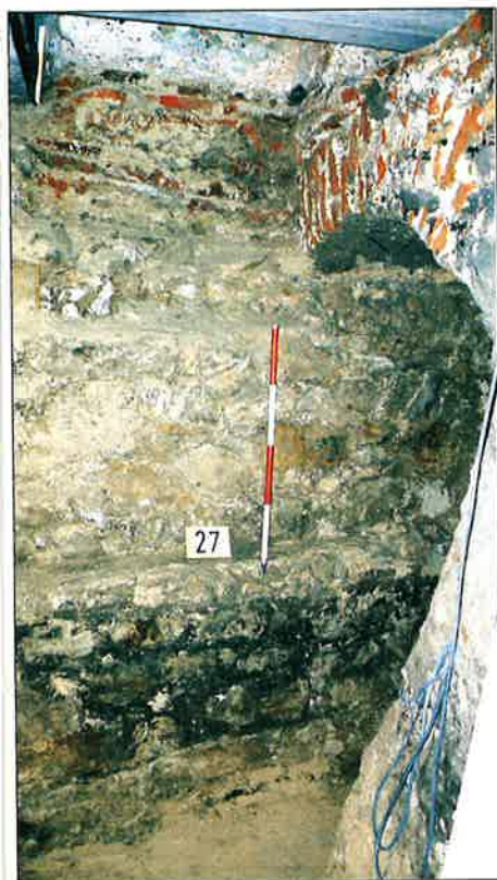
Ryc. 2. Lublin. Kamienica przy ul. Grodzkiej 30. Mur obronny. Widoczny jest łuk odciążający, na którym później zbudowano ścianę kamienicy. Fot. Andrzej Hunicz.
