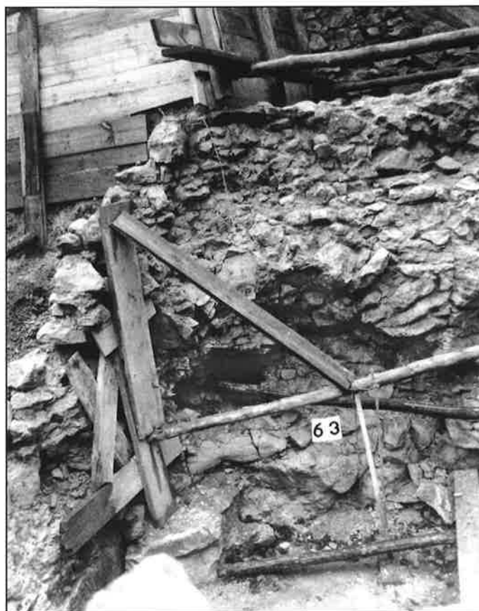
Fot. 2. Kazimierz Dolny – zamek. Relikty studni odkrytej na dziedzińcu – widok od wewnątrz. W dole fotografii czytelny prostokątny zarys studni wykutej w litej skale wapiennej, wyżej owalna cembrowina murowana z kamienia wapiennego.
