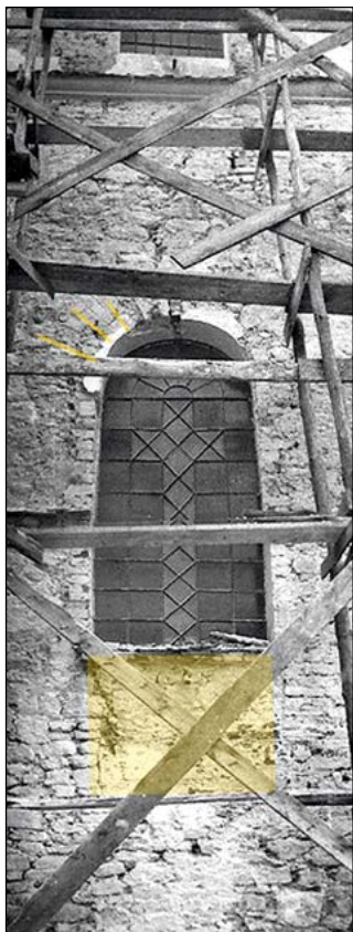
8. Zdj. lewej: Końskowola, okno zamknięcia prezbiterium od strony pn-wsch. po zbieciu tynków w trakcie remontu elewacji w 1979 r. Kolorem żółtym zaznaczona zamurowana dolna partia okna i układ kłińców w łuku otworu.
