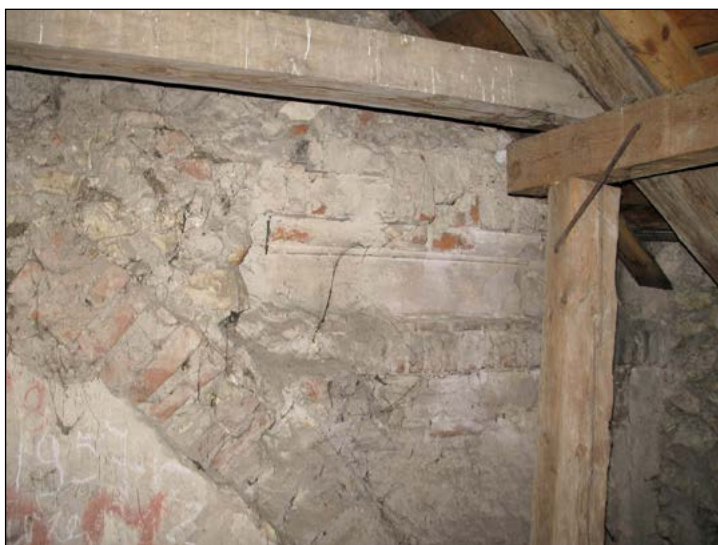
9. Końskowola, zachowany w partii poddasza na ścianie szczytowej fragment gzymsu wewnętrznego nawy gł. przecięty strzębami późniejszego sklepienia (po 1617 r.), fot. R. Zwierzchowski, 2008
