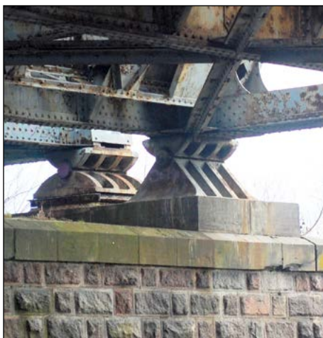
Rys. 16. Obrazy mostu w Szczekarkowie: a) widok na trzy przęsła kratownicowe b-c) skrajne ramy portalowe d) przęsło nurtowe e) filar nurtowy f) łożyska przegubowe mostu kolejowego, z lewej łożysko ruchome, z prawej łożysko stałe
