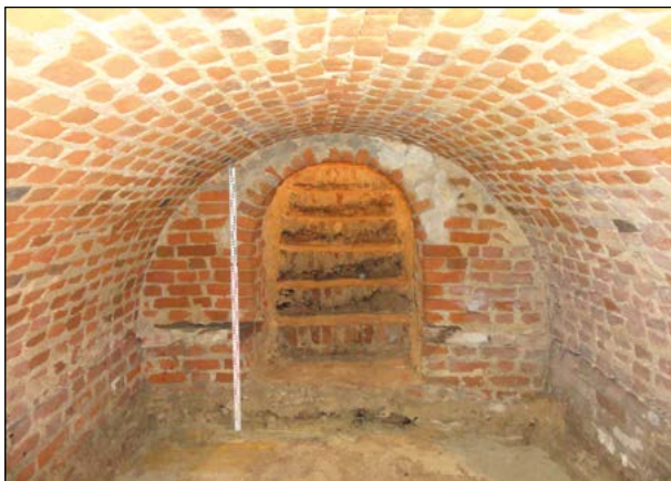
Fot. 4. Wnętrze i wejście do pomieszczenia krypty 1 po oczyszczeniu. Ujęcie od strony płn.
