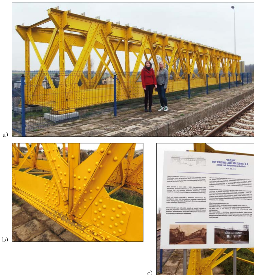
Rys. 19. Zabytkowa kratownica mostowa na stacji kolejowej w Ciecierzynie a) kratownica b) nitowany węzeł dolny kratownicy c) tablica informacyjna
