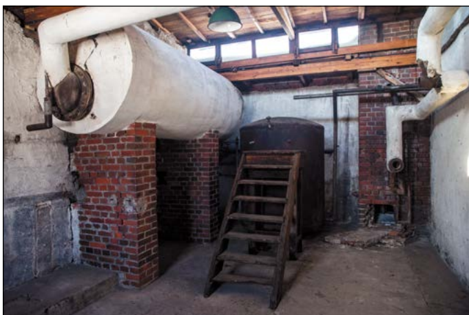
9. Barak łaźni żeńskiej - kotłownia, fot. Muzeum, 18.02.2021
