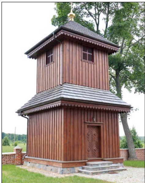
8. Horostyta, dzwonnica cerkiewna po pracach remontowo-konserwatorskich, fot. Paweł Wira, 2021 r.
