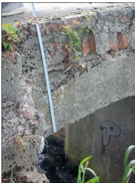
Rys. 11. Żelbetowy łuk mostu nad Kurówką w miejscowości Wólka Nowodworska a) widok od strony Kurowa b) widok od strony przeciwnej c) wysokość ustroju nośnego, w tym łuku żelbetowego
