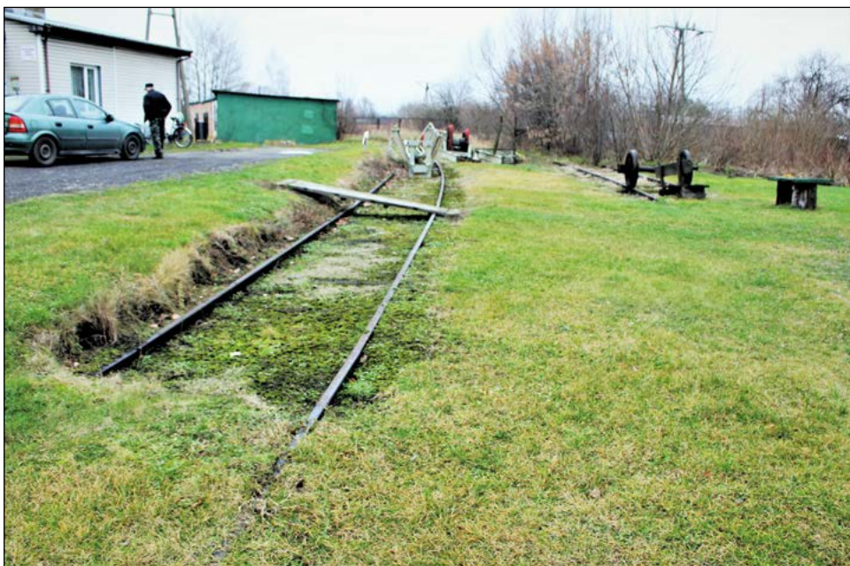
2. Terespol, fragment bocznicy kolejowej przy Prochowni, fot. A. Stawinoga, 2020
