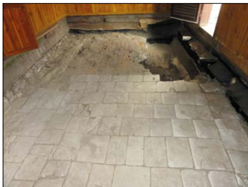
Fot. 11. Widok ogólny na oczyszczony poziom posadzki ceglano-wapiennej. Ujęcie od strony wsch.
