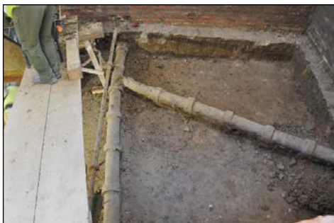
Rurarz dawnej instalacji wod.-kan., odkryty pod częścią zach. teatralni, fot. Muzeum Zamoyskich w Kozłowie
