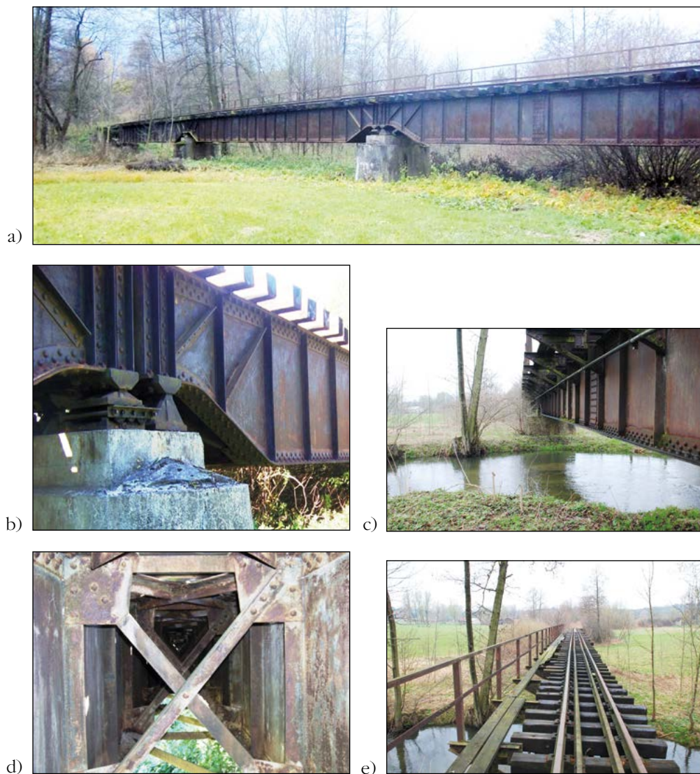
Rys. 4. Most NKD nad rzeką Bystrą w Mareczkach a) widok na cały most b)łożysko stałe i przesuwne na filarze c)przesło nurtowe d) kratowe stężenia poprzeczne e) nawierzchnia kolejowa na moście.
