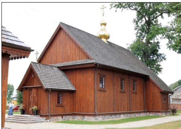
10. Horostyta, cerkiew prawosławna pw. Podwyższenia Krzyża Pańskiego po pracach remontowo-konserwatorskich, fot. Paweł Wira, 2021 r.
