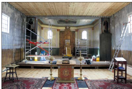
4. Horostyta, cerkiew prawosławna pw. Podwyższenia Krzyża Pańskiego, wewnątrz w trakcie prac remontowo-konserwatorskich, fot. Paweł Wira, 2020 r.
