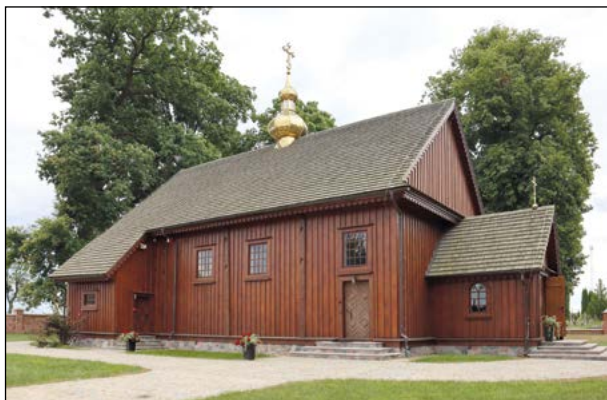
9. Horostyta, cerkiew prawosławna pw. Podwyższenia Krzyża Pańskiego po pracach remontowo-konserwatorskich, fot. Paweł Wira, 2021 r.
