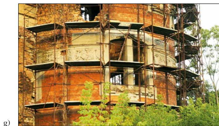
Rys. 2. Most na ul. Pliszczyńskiej w Lublinie i jego otoczenie: a) widok od napływu b) widok od odpływu c) widok spodu łuku d) przeciążenie mostu e) pozostałości boniowania f) pozostałości okładziny klinkierowej g) pałac, baszta z dekoracją.
