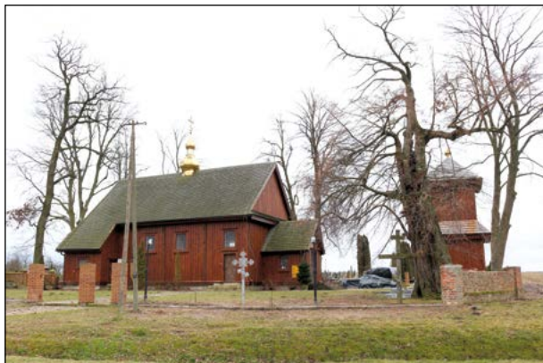
1. Horostyta, zespół cerkwi prawosławnej pw. Podwyższenia Krzyża Pańskiego, w trakcie prac remontowo-konserwatorskich, fot. Paweł Wira, 2020 r.
