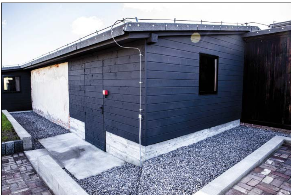
14. Łącznik między barakiem 41 a budynkiem komór gazowych, fot. Muzeum, 06.05.2021
