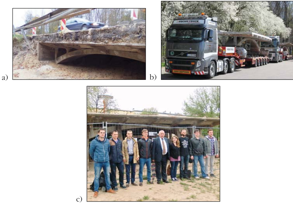
Rys. 7. Most z Łabuń DK 17 a) widok na most podczas remontu drogi b) most na lorach transportowych c) prof. Wacław Szczeciński ze studentami KDiM na tle mostu
