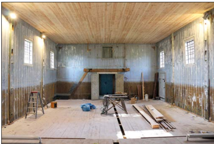
5. Horostyta, cerkiew prawosławna pw. Podwyższenia Krzyża Pańskiego, wnętrze w trakcie prac remontowo-konserwatorskich, fot. Paweł Wira, 2019 r.
