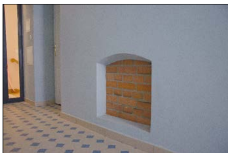
Oficyna pld., korytarz piętra – wnęka „wyczystki” piecowej, fot. M. Kurczewicz 2021
