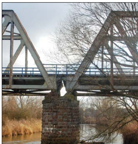
Rys. 16. Obrazy mostu w Szczekarkowie: a) widok na trzy przęsła kratownicowe b-c) skrajne ramy portalowe d) przęsło nurtowe e) filar nurtowy f) łożyska przegubowe mostu kolejowego, z lewej łożysko ruchome, z prawej łożysko stałe
